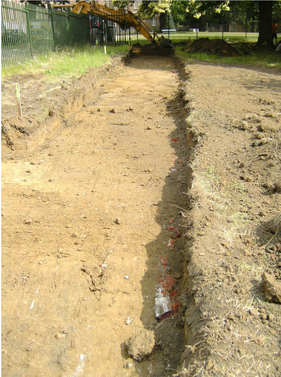
Figuur 61. Een bakstenen fundering parallel aan de oostelijke rand van wegkoffer WP9. (Foto Triharch)
