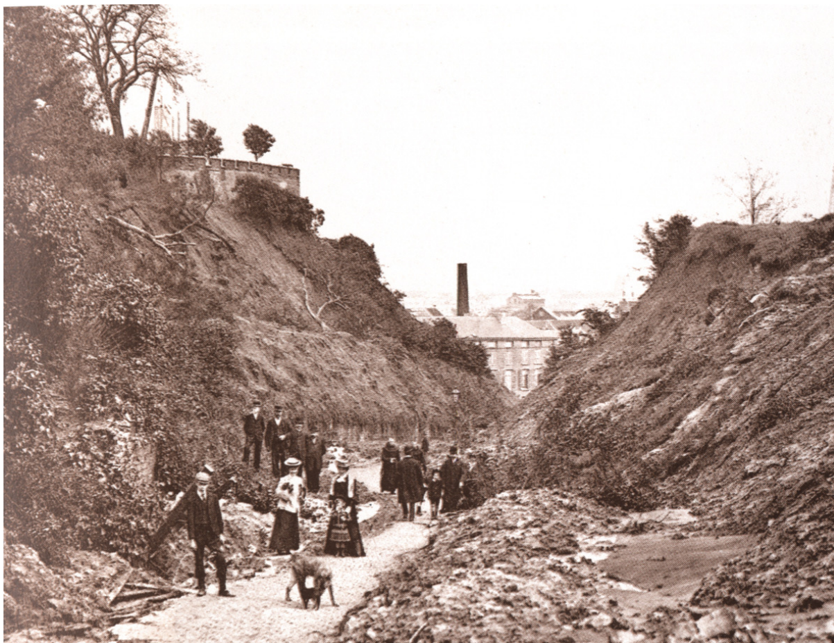
Figuur 17. Foto van de grote grondverzakkingen in de Mechelsestraat ter hoogte van Keizersberg (1906). (Bron: archief abdij Keizersberg)
