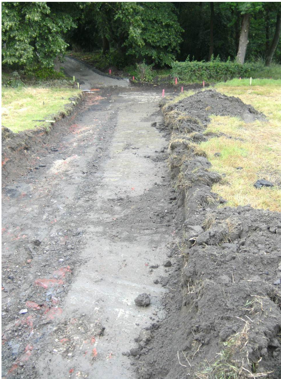
Figuur 55. Resten van een vroegere wegbedding uit baksteenpuin en asse in WP4. (Foto Triharch)
