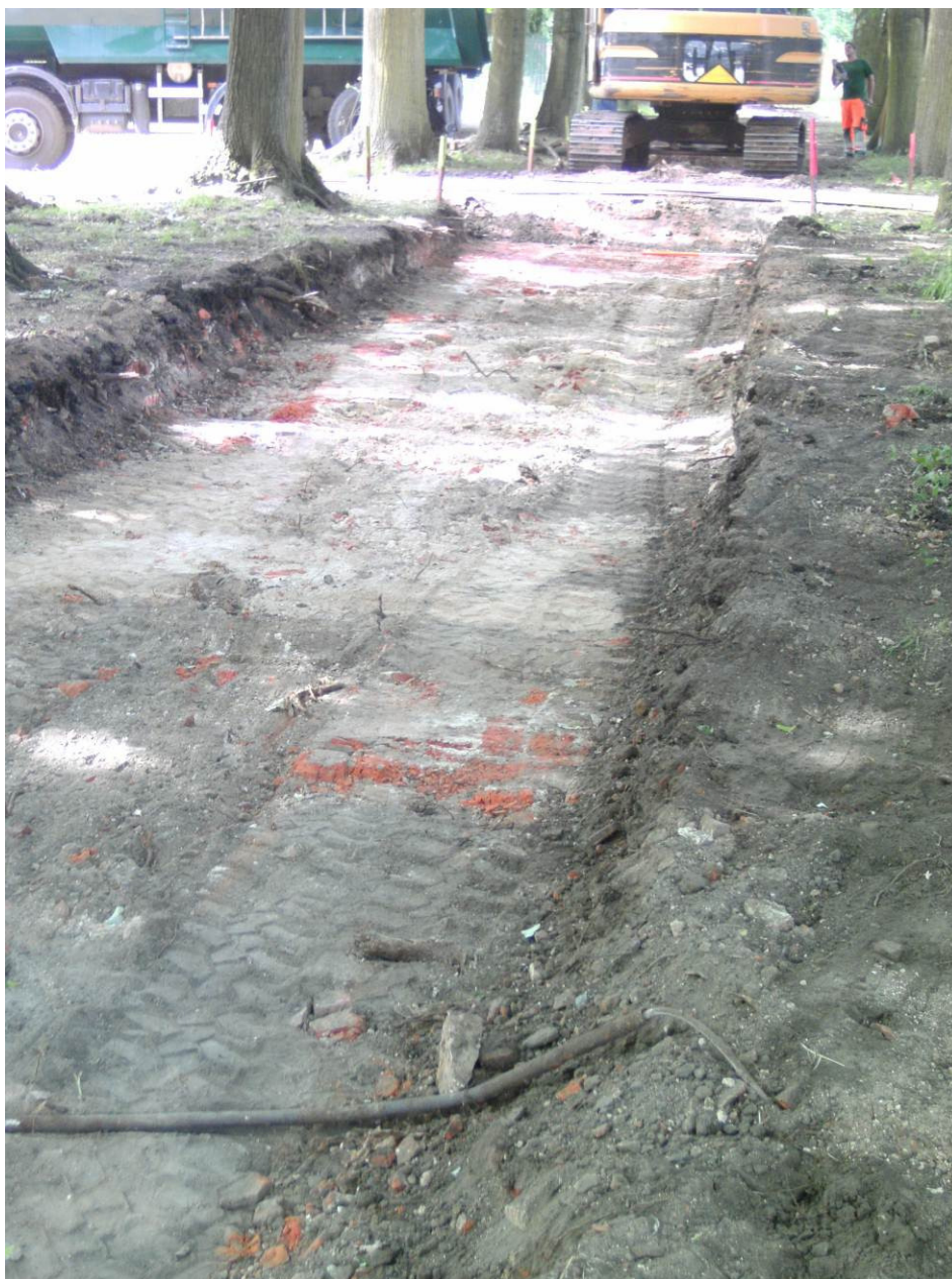
Figuur 58. Funderingen in baksteen en natuursteen in het noordelijk deel van WP6. (Foto Triharch)
