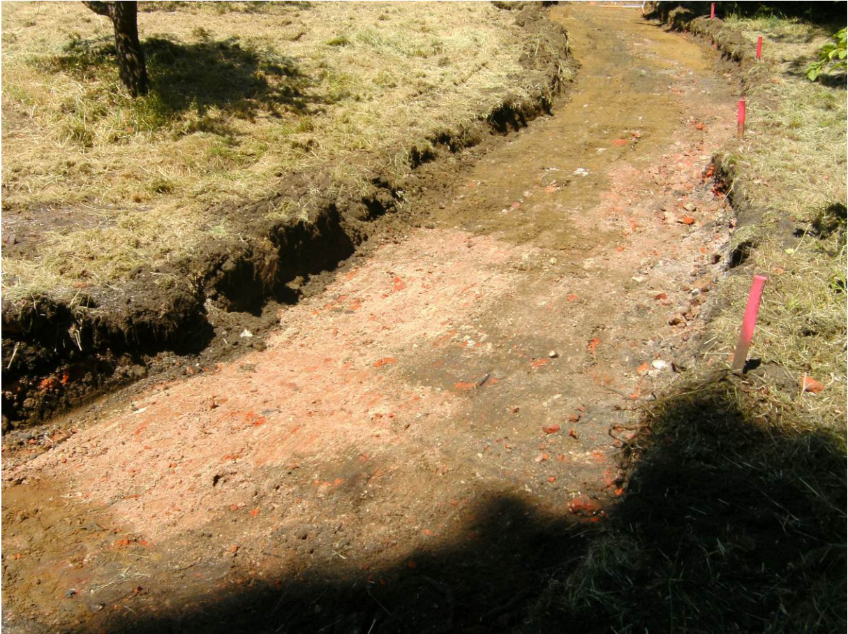
Figuur 52. Wegkoffer WP1 met lagen baksteenpuin en asse. (Foto Triharch)
