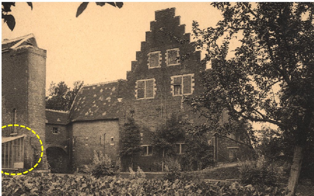
Figuur 29. Foto 4.3 van de hoeve van de commanderij met links zicht op de serre (gele cirkel).
