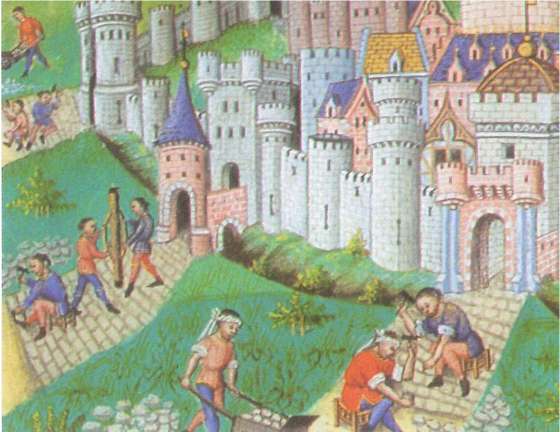
Figuur 27. Kasseien werden gelegd en aangestampt in een onderlaag van aarde. Met uitzondering van het gebruik van moderne werktuigen is de techniek in de loop van de tijd weinig veranderd. Uitsnede van een miniatuur uit de 15e eeuwse Chroniques de Hainaut (bron: Koninklijke Bibliotheek van België, Ms. 9242, fol. 45, Brussel).
