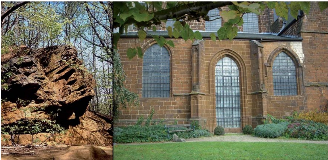
Figuur 9. Op de Wijngaardberg zijn nog groeven herkenbaar waar ijzerzandsteen werd gewonnen (links). Ook de middeleeuwse kerk van Wezemaal was voor een groot deel opgebouwd uit ijzerzandsteen (rechts).
