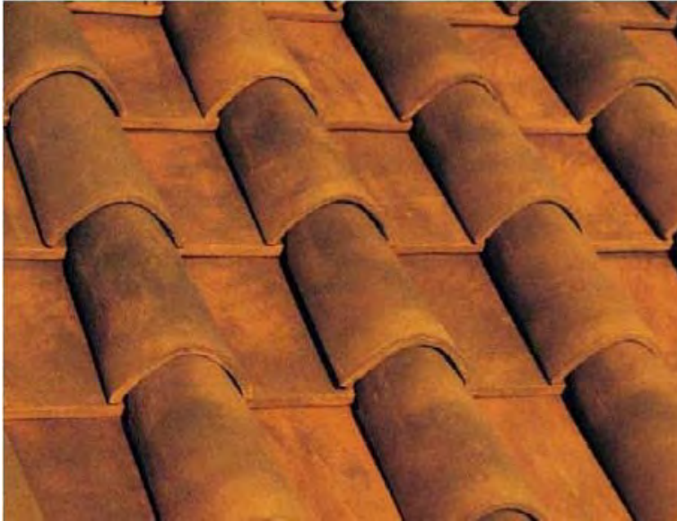
Figuur 45. Reconstructie van Romeins dak. De platte pannen zijn de tegulae; de gebogen pannen de imbrices. Bron: bouwencyclopedie: www.joostdevree.nl .
