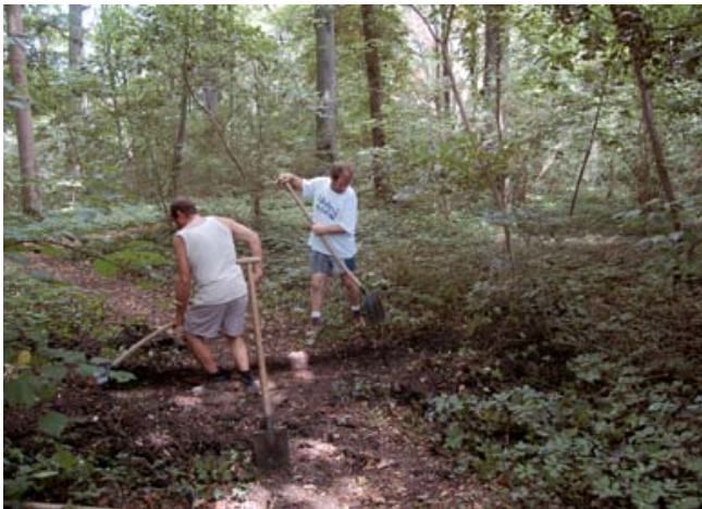
FIG. 46 Excavating by hand. Opgraven met de hand.
