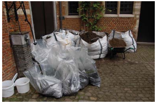
FIG. 99 The excavated spoil was stored in large big bags. De opgegraven grond werd gestockeerd in stevige grote big bags.
