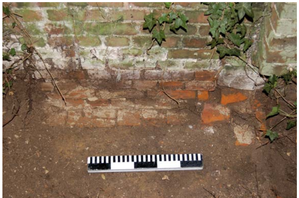
FIG. 50 Trench 12 at the east gate. Sleuf 12 aan de oostpoort.
