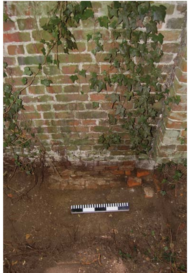
FIG. 85 Blocked east gateway. Afgesloten oostelijke poort.
