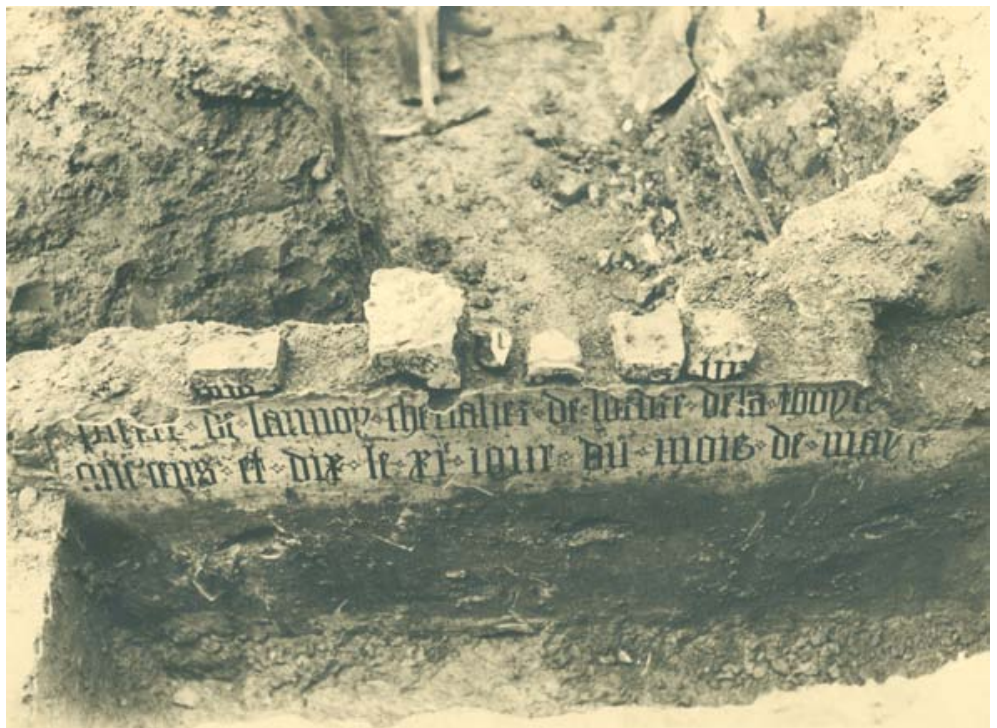
FIG. 57 De graafwerken voor de constructie van de ondergrondse bunker brachten het graf van ridder Pierre de Lannoy aan het licht (Foto: Stadsarchief Aalst). The excavation works for the construction of the shelter revealed the tomb of the knight Sir Pierre de Lannoy (Photo: Municipal Archives Aalst).
