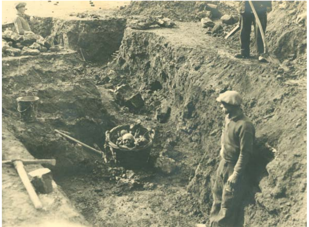
FIG. 56 De aanleg van de bunker voor de Passieve Luchtbescherming in 1941 vernielde een belangrijk deel van de graven in de karmelietenkerk (Foto: Stadsarchief Aalst). The construction of the shelter of the Passive Air Protection in 1941 destroyed an important part of the burials in the Carmelite church (Photo: Municipal Archives Aalst).
