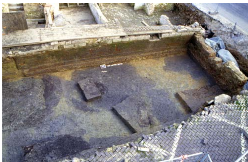
FIG. 22 De westelijke buitenzijde van de nieuwe zaal had een parament van kalkzandsteen, dat plaatselijk twee steenlagen hoog bewaard was. Rechts is de er tegenaan gebouwde bakstenen muur van de zuidvleugel zichtbaar. The western outer wall of the second west wing building had a parament in calcareous sandstone, which in places had been preserved to a height of two layers. The brick foundation of the south wing is visible on the right.
