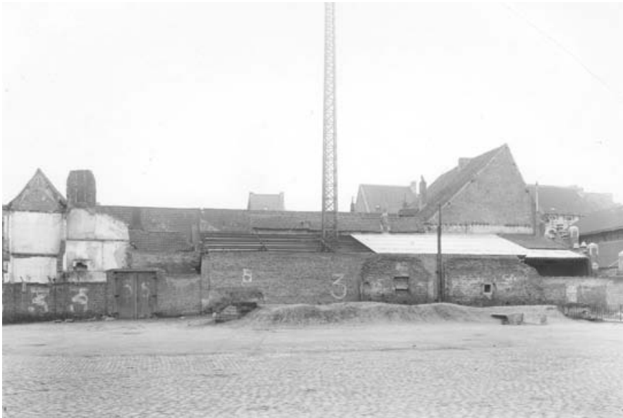
FIG. 50 Zicht vanuit het noorden op het resterende gebouwpatrimonium van het karmelietenklooster na 1941. Links is het puntdak te zien van de huisjes die in de oostelijke pandgang gebouwd zijn. De brede puntgevel rechts is afkomstig van de westvleugel, die toen nog grotendeels bewaard was. De kloosterkerk vooraan is afgebroken waardoor gekeken wordt op de afsluitende muur van de noordelijke pandgang. Vooraan is de grondophoping te zien van de ondergrondse bunker, met aan het uiteinde rechts de toegang (met hek) en links de oostelijke nooduitgang (Foto: Stadsarchief Aalst, verzameling De Rouck).
