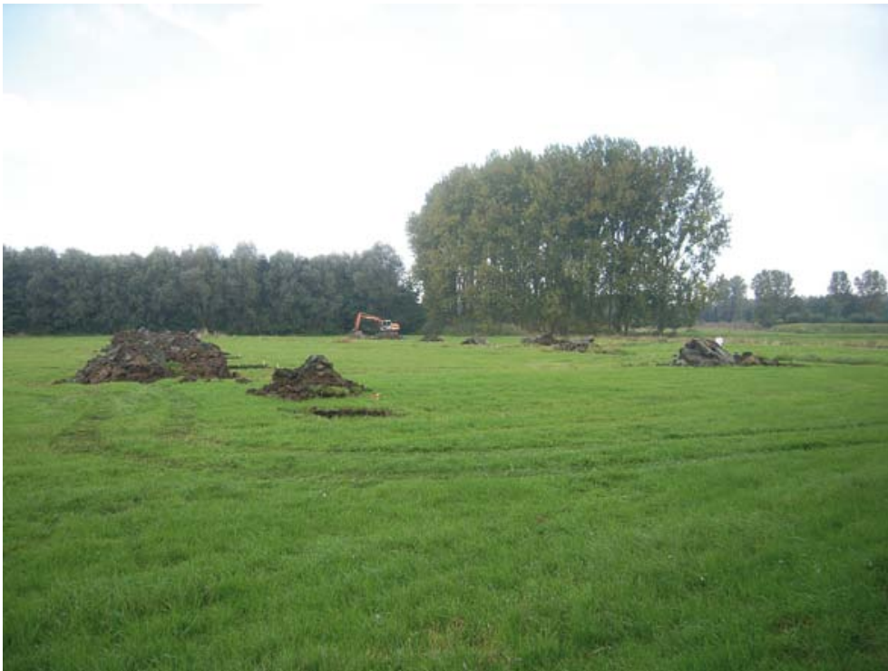
FIG. 11 Aanleg van de proefputten in zone WME. The digging of the test pits in the WME area.
