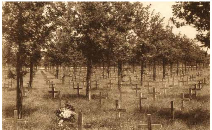
ABB. 26 Langemark: Foto des Gräberfeldes von ca. 1946 (Archiv VDK). Langemark: foto van de begraafplaats, ca. 1946 (Archief VDK).
