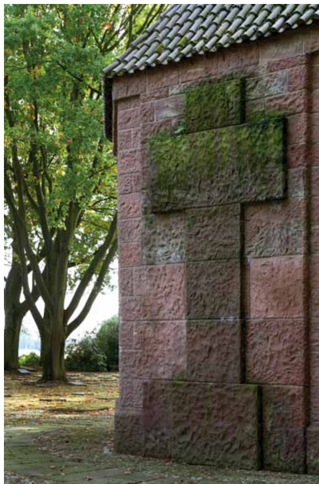
ABB. 63 Die Rückseite der Kapelle in Menen trägt ein heute stark vermodertertes Kreuzrelief (Foto 2009, Kris Vandevorst). De achterkant van de kapel in Menen is voorzien van een inmiddels sterk verweerd kruisrelief (Foto 2009, Kris Vandevorst).
