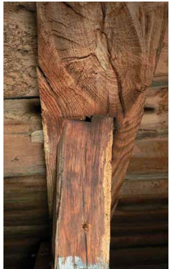
FIG. 18 Pen-en-gatverbinding van een stijl in een spoor (THOC, mei 2007).
