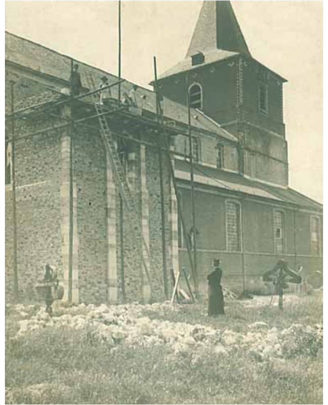
FIG. 5 Reconstructie van de noordelijke arm van het transept van de Sint-Hilariuskerk van Bierbeek tijdens de tweede fase van de restauratiewerken, 1905 (Universiteitsarchief Leuven, Archief Lemaire).
