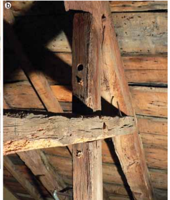
FIG. 19 Verbindingen tussen spoor, stijl en hanenbalk (THOC, mei 2007). Joints between a rafter, a post and a collar (THOC, May 2007). Assemblages d'un chevron, d'un poteau et du faux-entrait (THOC, mai 2007).
