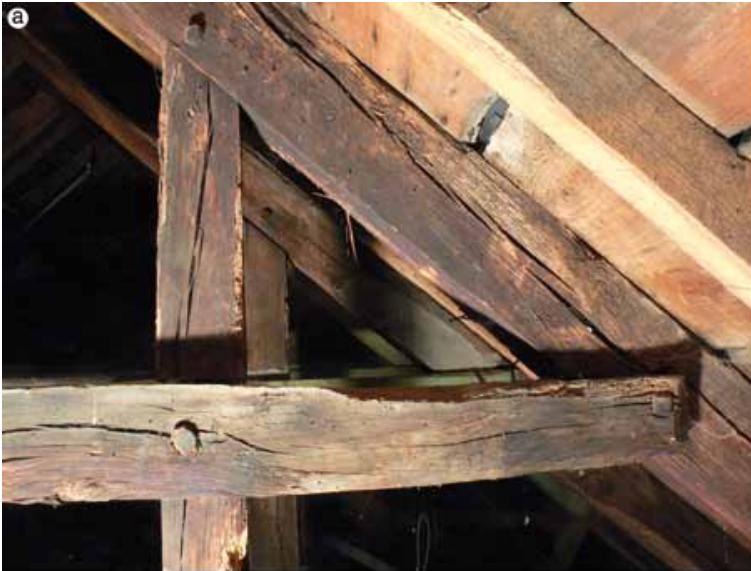
FIG. 19 Verbindingen tussen spoor, stijl en hanenbalk (THOC, mei 2007). Joints between a rafter, a post and a collar (THOC, May 2007). Assemblages d'un chevron, d'un poteau et du faux-entrait (THOC, mai 2007).
