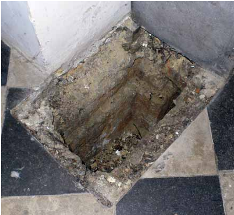
FIG. 8 Het middeleeuwse vloerniveau van het schip bevindt zich 40 cm lager dan het huidige vloerniveau; noordwest pijler van de kruising (THOC, mei 2007).
