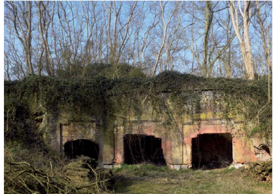
FOTO 9: Linker Halve Caponnière Fort Steendorp in Temse (foto K. Vandevorst) Het Fort Steendorp is onderdeel van de buitenring van de Brialmont fortengordel rond Antwerpen en werd gebouwd tussen 1883 en 1892. Het fort was achtereenvolgens een versterking, een munitiedepot van de Duitsers, een oefenterrein voor het leger en tenslotte een natuurgebied. De hoge vochtigheidsgraad, de vorstvrije temperatuur van de ondergrondse gewelven en de rust maken van dit fort de ideale overwinteringsplaats voor zeker acht verschillende vleermuissoorten, waaronder de ingekorven vleermuis en de meervleermuis.
