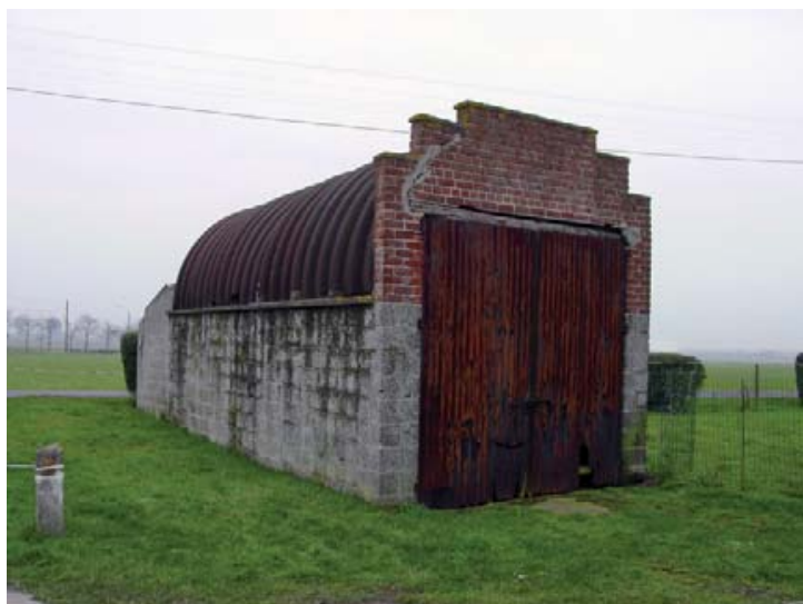
FOTO 25: Garage opgetrokken in recuperatiemateriaal uit WO I in Boezinge (foto N. Bogaert & H. Decoodt) Garage in de Bikschootsestraat in Boezinge, opgetrokken uit olifantenplaten en ander materiaal van een bunker uit WO I.
