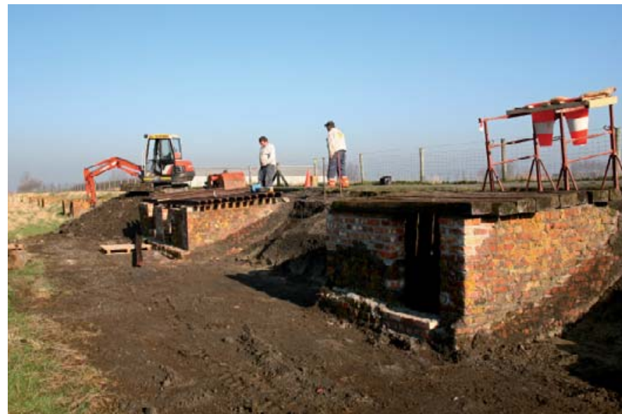
FOTO 52: Schuilplaatsen Frontzate tijdens reconstructie (foto K. Vandevorst) Plaatsing van spoorwegrails (linker schuilplaats) en biels (rechter schuilplaats) ter ondersteuning van de dakbedekking
