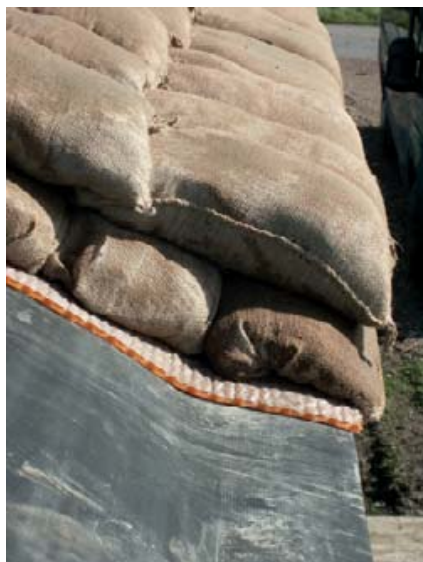
FOTO'S 48 en 49: Dakopbouw bunker Groigne tijdens consolidatie (foto's W. Hulstaert)
