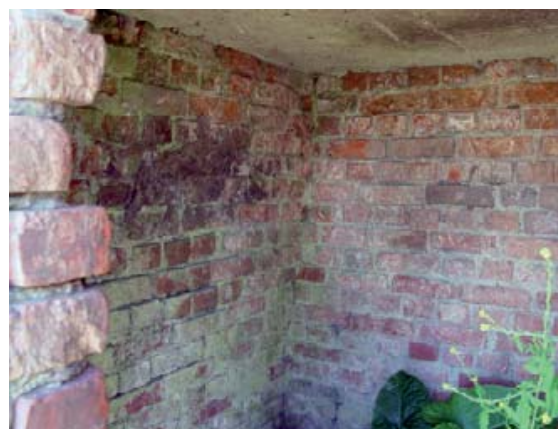
FOTO'S 23 en 24: Bakstenen schuilplaats uit WO I in Beerst (foto N. Bogaert & H. Decoodt) Een buiten- en binnenzicht van een bakstenen schuilplaats opgetrokken in WO I en gelegen aan de Galileistraat.
