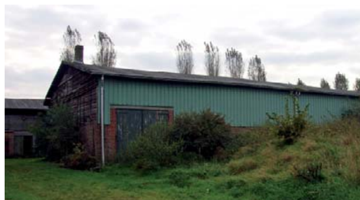
FOTO'S 63 en 64: Barakken pionierspark WO I in Jabbeke (foto's A. Verdonck) Kleine en grote barak in houtskeletbouw met muurvlakken in baksteen metselwerk op bakstenen onderbouw, gebouwd door het Duitse leger in de periode 1915-16 en gebruikt als opslagplaats. In het interbellum werden de barakken hersteld voor gebruik door Belgische genietroepen en in WO II werden de barakken opnieuw bezet, eerst door de Duitsers en nadien door het Engelse leger (gebruik als opslagruimte en feestzaal als deel van een gevangenkamp). De kleine barak werd zwaar beschadigd en gedemonteerd na een voorjaarsstorm in maart 2008. De grote barak is voorlopig beschermd.
