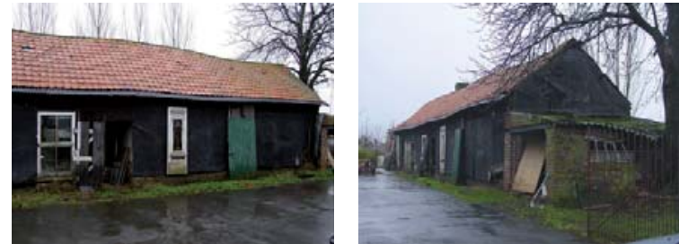
FOTO 69 en 70: Noodwoning 1920 in Sint-Juliaan (foto's N. Bogaert & H. Decoodt) Noodwoning bestaande uit een woonvertrek en 2 slaapkamers, opgetrokken in 1920 door de familie Masschelein-Herman.
