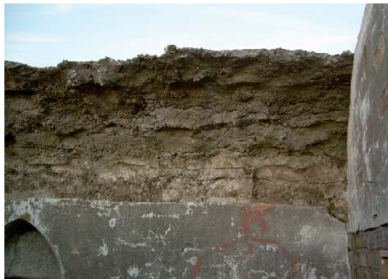
FOTO'S 45, 46 en 47: Bunker Groigne vóór consolidatie (foto's K. Vandevorst)
