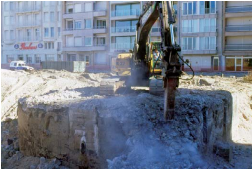
FOTO 27: Afbraak van een bunker aan het Rubensplein in Knokke (foto M. Dewilde) Bij de aanleg van een ondergrondse parking werd een bunker, die deel uitmaakte van de Atlantikwal (WO II), in 2002 afgebroken. De bunker werd door onderzoekers van het VIOE volledig gedocumenteerd vóór de afbraak.
