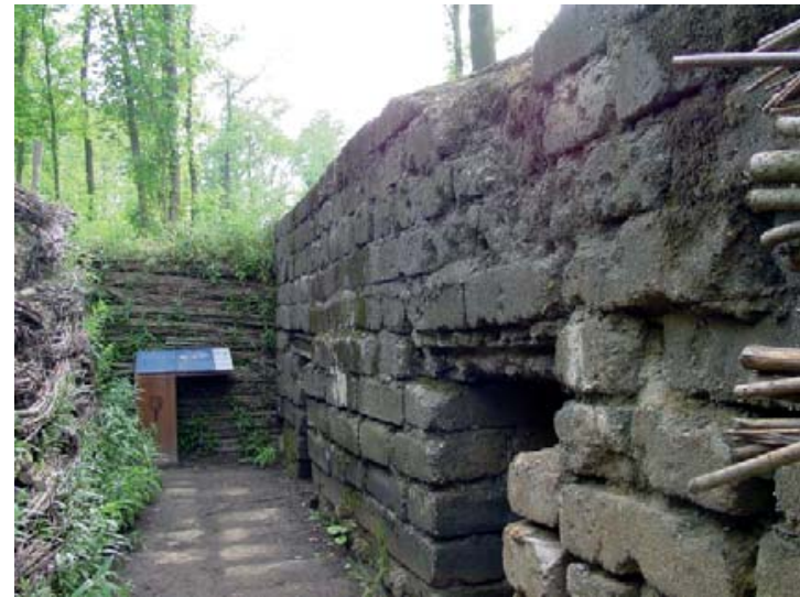
FOTO 20: Duitse bunker in prefab betonstenen in Bayernwald-Wijtschate (foto N. Bogaert & H. Decoodt)
