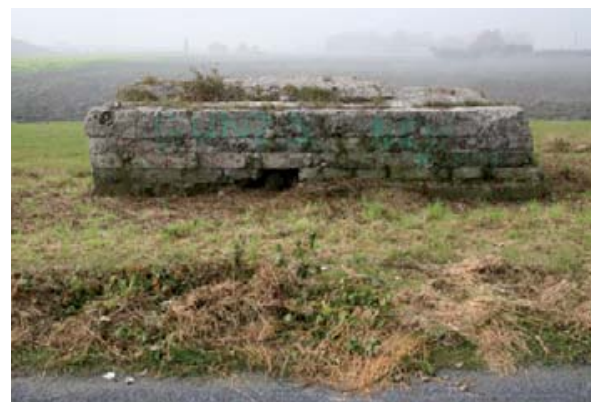
FOTO'S 35, 36, 37 en 38: Mitrailleurbunker Frontzate in Ramskapelle voor en na onderhoud/herstel (foto's K. Vandevorst) De Oost- en westgevel van de bunker vóór en na onderhoud en herstelacties.
