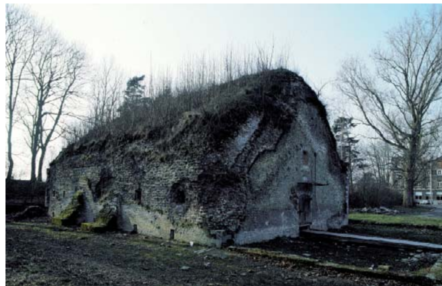
FOTO 12: Overwoekerd kruitmagazijn (Esplanade) in Ieper (foto O. Pauwels) Dit kruitmagazijn (foto met overwoekerd dak vóór restauratie) is gelegen te Ieper en werd opgetrokken in de periode 1817-1818. Het werd beschoten in de beide wereldoorlogen maar hield stand dankzij de 3m dikke muren. In 1997-98 werd het gebouw gerestaureerd en werd er een audiovisuele voorstelling in ondergebracht met als onderwerp '1000 jaar vestingbouw in 10 minuten'.
