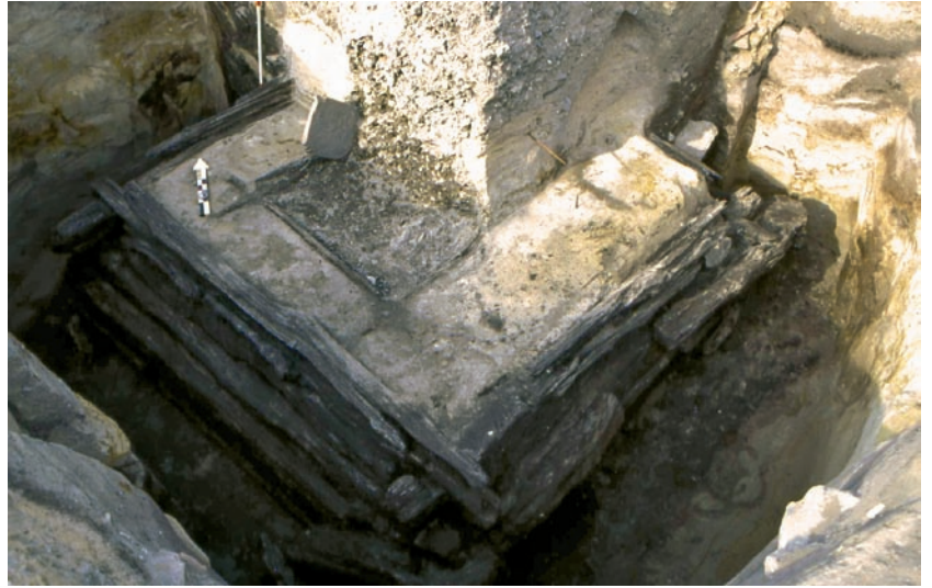
FIG. 8 De buitenbekisting van OS 2562, deels vrijgelegd. The outer framework of OS 2562, partly exposed.
