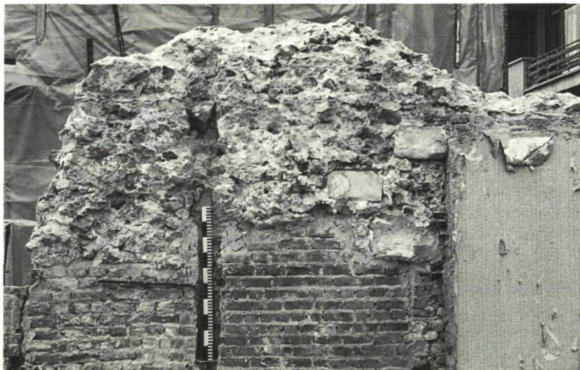
4 Zicht op coupelijn A-B van fig. 2 vanuit het westen, met middeleeuwse muur in silex en mergel, ondermetseld door recente baksteenmuur.
