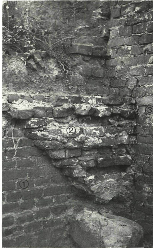
11 Drie bouwfases in één hoek: muur 1 ligt onder muur 2, op haar beurt overbouwd door muur 3 (cf. fig. 10: muren 5, 6 en 7).
