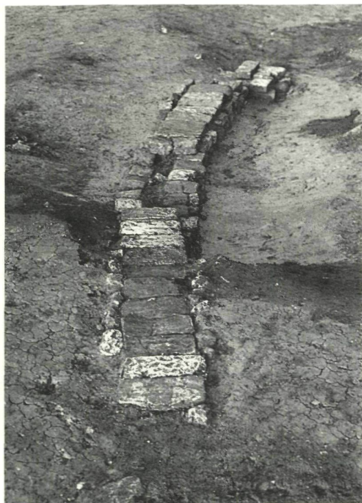
11 Riolering in baksteen. Canalisation en briques.
