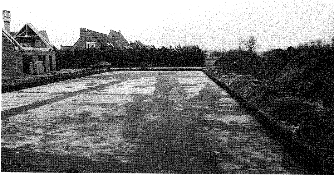
4-5 Het terrein tijdens de opgravingen. The excavation in progress.
