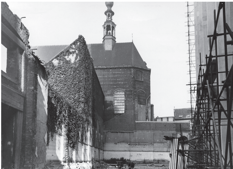
3 Het voormalige Allerheiligenklooster tijdens de bouw van de politietoren (SA). The former All Saints' Monastery during the building of the police tower.
