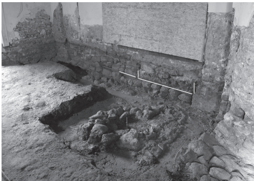
15 Noordmuur van de westinkom met de bouwnaad die de, later dichtgemaakte, doorgang aangeeft. North wall of the western entrance hall with the blocked passage.
