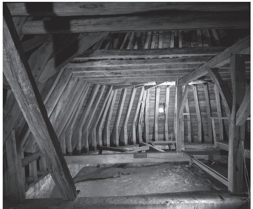
9 Onderste deel van de kap boven de gewelven van het koor. Lower part of the timber structure above the vaults of the choir. (© Oswald Pauwels 2001)
