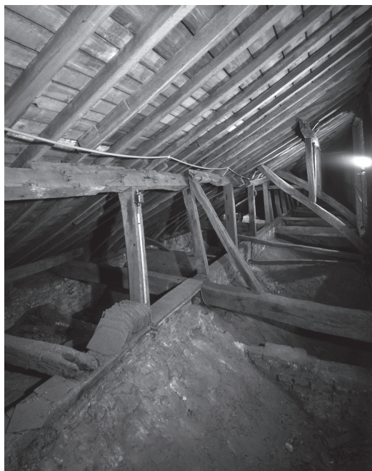
21 Kap boven de zuidelijke zijbeuk, naar het westen gezien.
