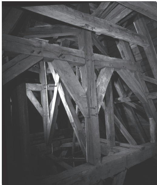
12 Houtconstructie van de dakruiter. Timber structure of the roof-turret. (© Oswald Pauwels 2001)
