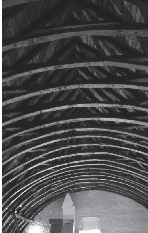
29 De ziende kap van het dormitorium. Timber open roof of the dormitory.
