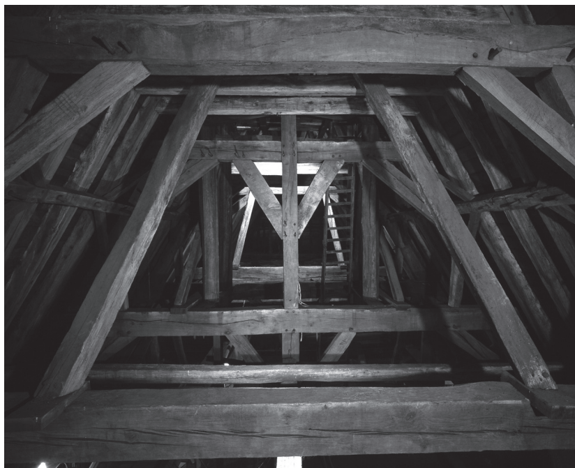
20 In de 18de eeuw werd de dakruiter naar het oosten verplaatst en verstevigd.
