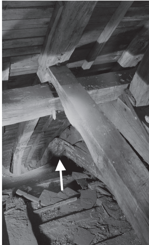
16 Op de booggebinten geven dunne witbeschilderde plankjes (piltje), oorspronkelijk zichtbaar vanuit het schip, het tracé van de beschieting van het verdwenen tongewelf aan.
