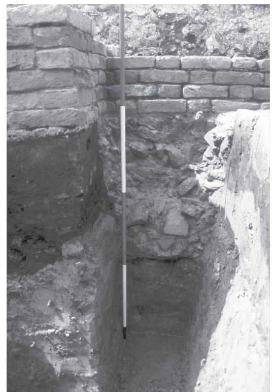
14 Detail van een steunbeer. Bemerkt het zwarte pakket onder de steunbeer en het funderingspakket van bakstenen onder de muur. A buttress in detail showing the black layer below the buttress and the layer with bricks below the wall.
