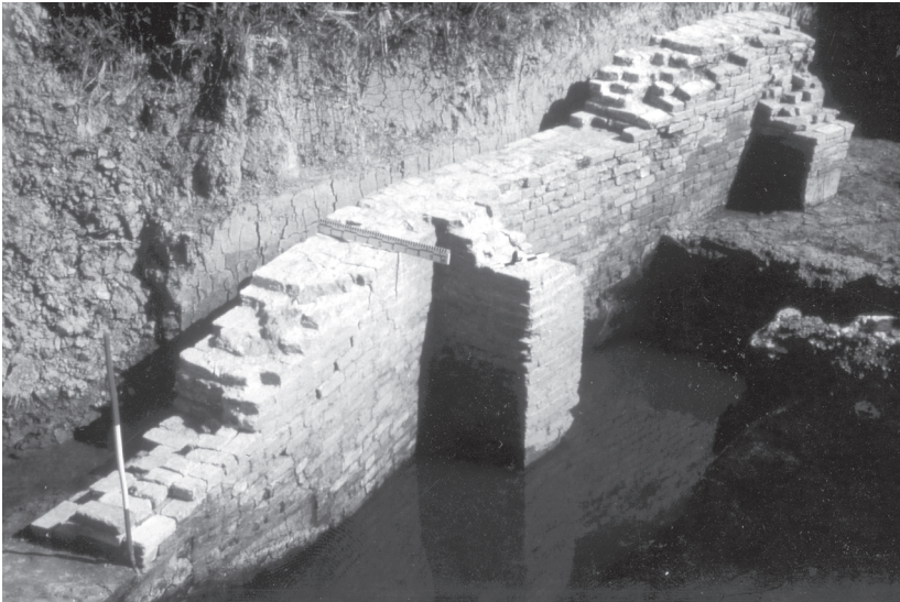
4 Eén van de muren nabij de toegang tot het Groot-Tempelhof. One of the brick walls near the entrance to the site 'Groot-Tempelhof'.
