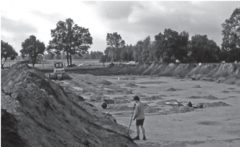
4 Onderzoek tijdens de egalisatiewerken. Investigation during the works.
