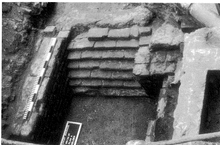
24 Stortgat in de noordelijke muur van de buitenkelder. Vent-hole in the northern wall of the cellar.
