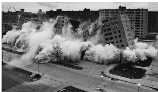
Demolición del conjunto residencial Pruitt-Igoe, St Louis
