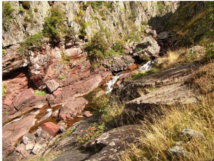
Figura 13. Tramo AS 03, excavado en roca y de difícil acceso.
