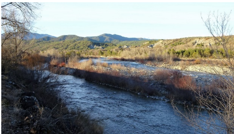
Figura 46. Tramo final AR 14 aguas arriba de Aínsa.
