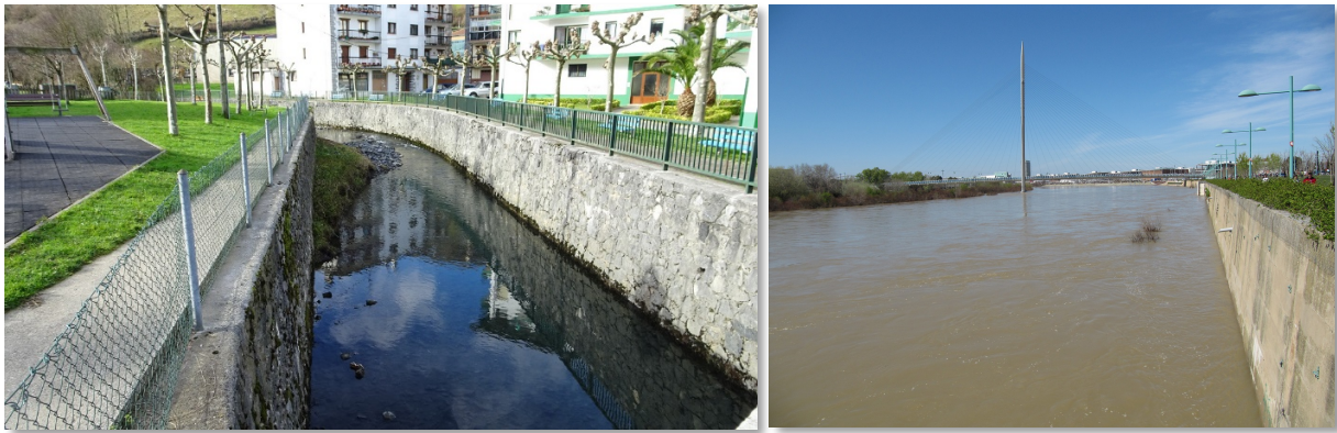
Figura 84. Canalización del río Leizaran a su paso por Leiza (izquierda) y muro lateral en el Ebro en Zaragoza (derecha).
