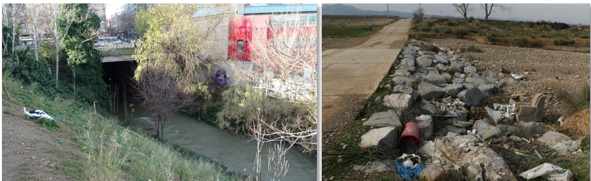
Figura 85. Soterramiento del río Huerva en Zaragoza (izquierda) y acumulación de basura y defensa frente la erosión aguas abajo de un vado en la rambla de Cariñena (derecha).
