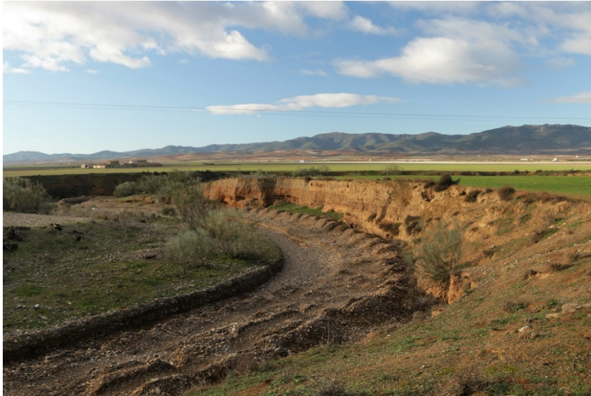
Figura 51. Tramo FR 03 en la zona media.
