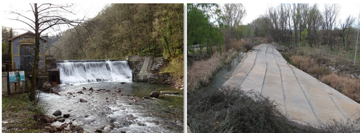
Figura 81. Presa de Olaberri, con escala de peces, en el río Leitzarar (izquierda) y obstáculo mixto (paso sobre paramento y salto vertical) sin escala de peces en el río Huerva (derecha).
