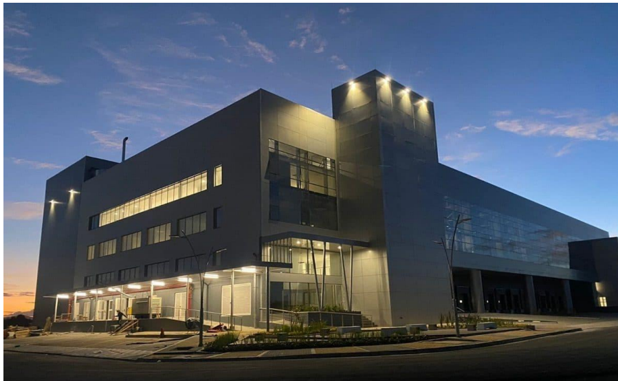
Figura 3. El cuarto foco. Construcción del nuevo CEDI automatizado Aurora
