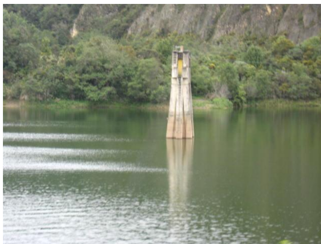
Foto N° 2: Captación de descarga en el embalse de Neusa.
