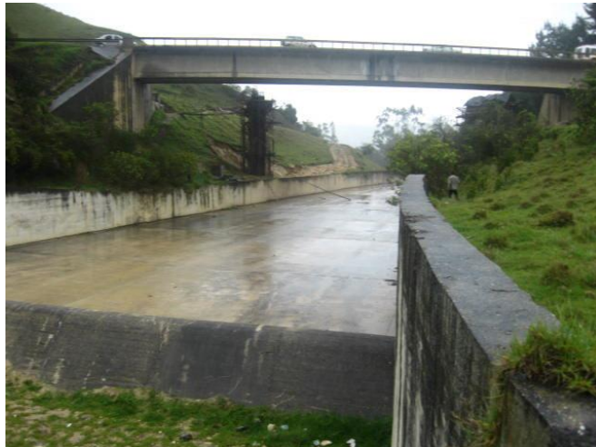
Foto N° 14: Sistema de rebosamiento del embalse de Sisga.
