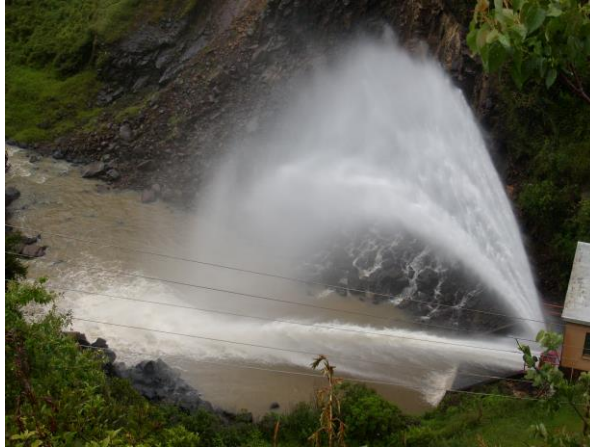
Foto N° 23: alcance de descarga del embalse de Sisga.
