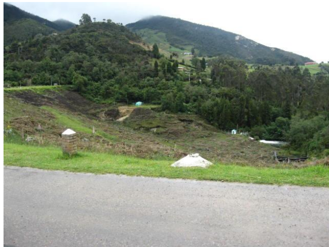
Foto N° 8: talud del embalse de Neusa
