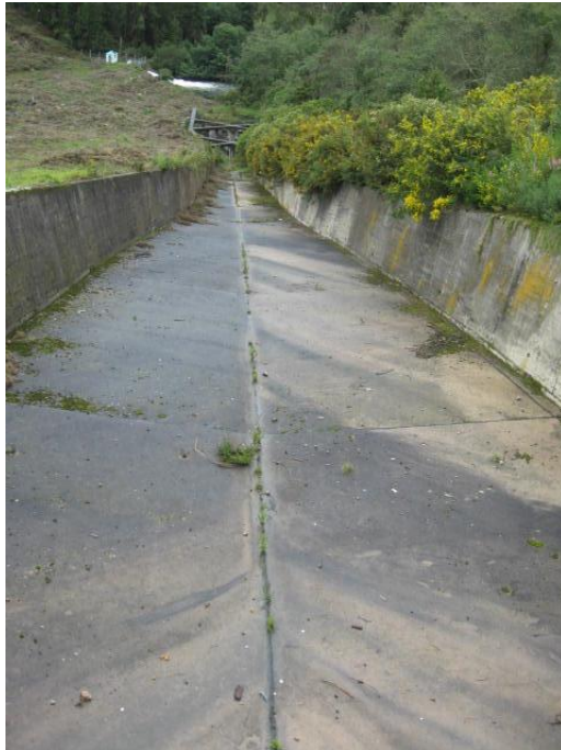
Foto N° 7: canal de rebose de embalse de Neusa
