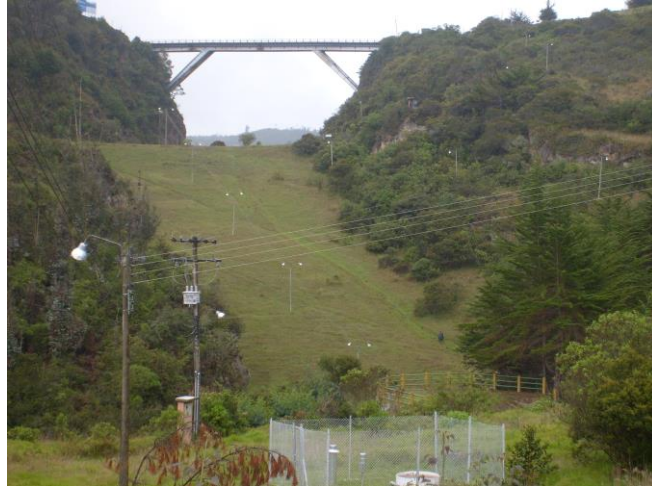
Foto N° 15: talud del embalse de sisga.
