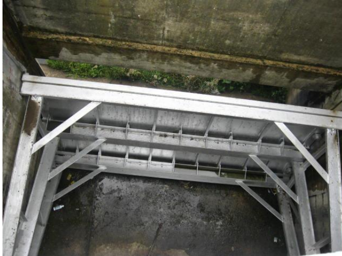
Foto Nº 9: Compuertas de rebose de embalse de Neusa.
