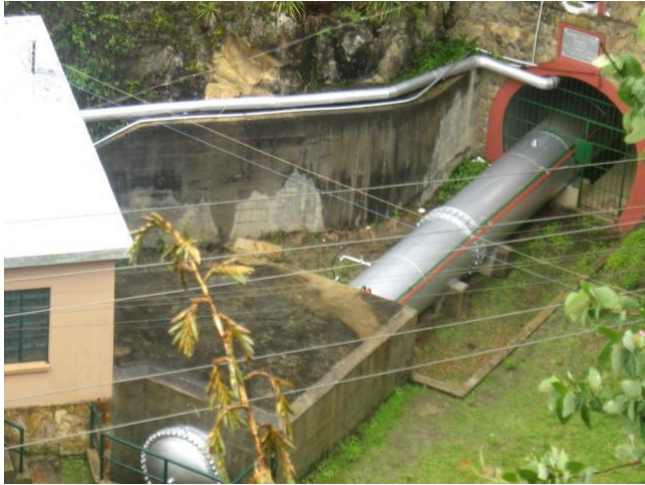
Foto N° 18: tubería de descarga de embalse de Sisga.
