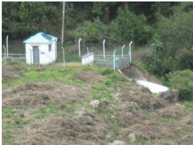
Foto N° 6: válvulas de control de descarga del embalse de Neusa.
