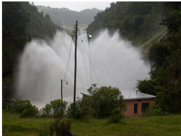
Foto N° 24: Sistema de descarga – desenergización de embalse de Sisga.
