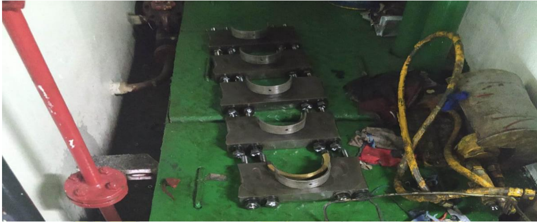
Pelepasan metal jalan untuk perawatan dan pengecekan
