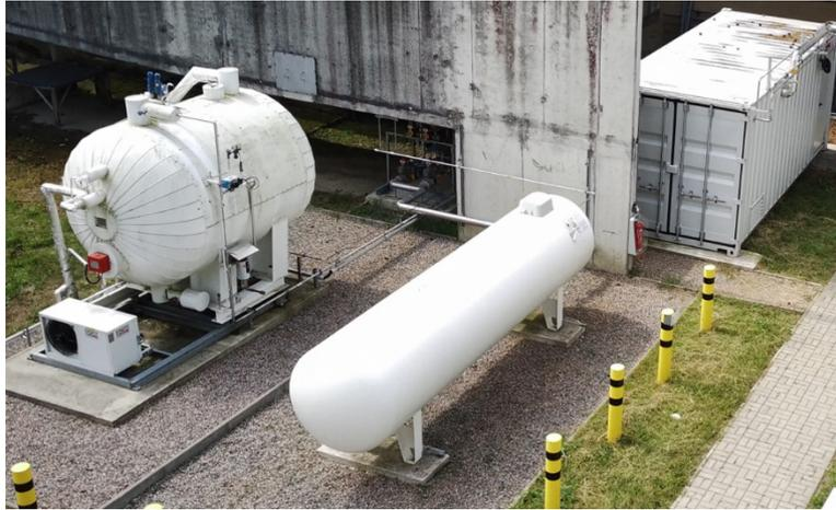
Abbildung 3.4 Gasmischanlage des 1/34DF; im Vordergrund die beiden Tanks zur Lagerung der Beimischgase CO<sub>2</sub> (links) und C<sub>3</sub>H<sub>8</sub> (rechts); im Hintergrund die Mischstrecke als Containerlösung
