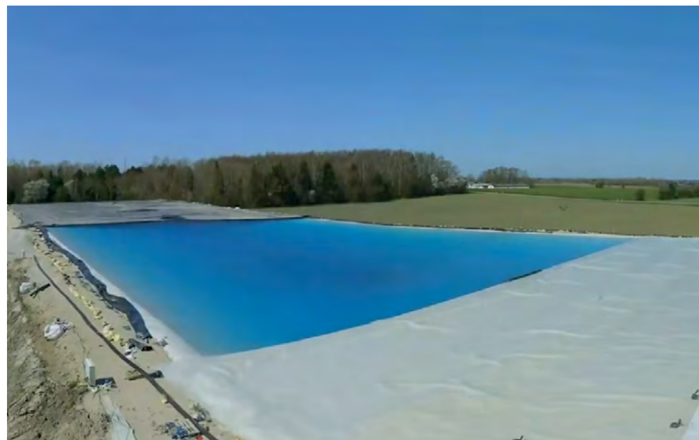
Damvarmelager på 70.000 m 3 i Høje Taastrup under etableringsfasen.
