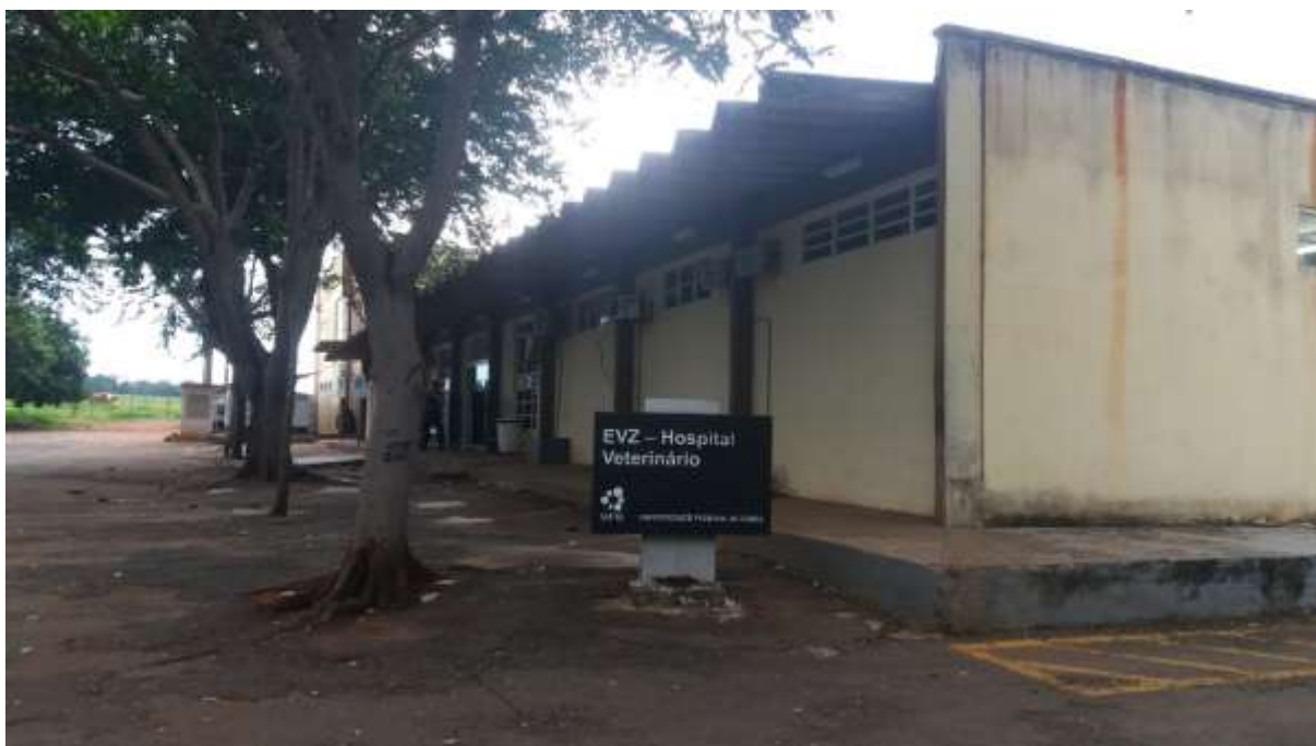
Figura 1 - Fachada do Hospital Veterinário da Escola de Veterinária e Zootecnia, no Campus Samambaia da Universidade Federal de Goiás (UFG). Fonte: Arquivo Pessoal, 2016
