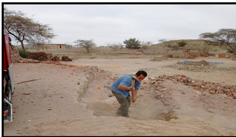
FOTO N°2: se observa como es que el peón que nos ayudo en el desarrollo de la tesis extrae materia prima para luego elaborar la mezcla
