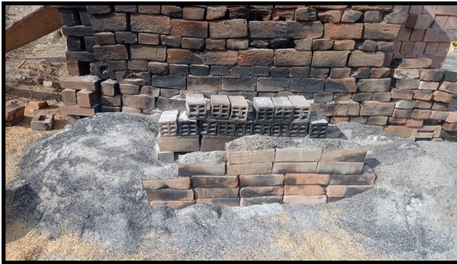
FOTO N°5: se observa en esta imagen como es que el ladrillo es quemado en el horno por un promedio de 10 a 14 días con un tiempo de enfriamiento de 4 días
