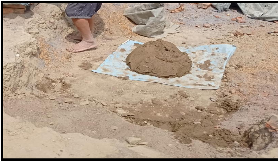
FOTO N°3: se observa cómo se va amasando el material para la elaboración del ladrillo artesanal
