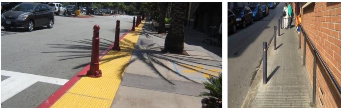
Figura 87. Bolardos de contraste cromático adecuado y alineados al borde de la calzada.
