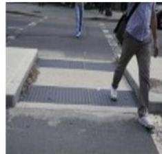
Fig 10: Mediana de ancho menor a 6 m que mantiene todo el ancho del cruce al nivel de la calzada. Foto 6: Mediana rebajada a nivel de la calzada con pavimento de abría en el inicio y término de ésta.
