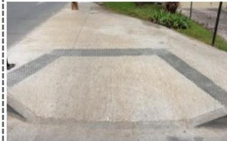
Foto 13: Alternativa de ampliación de una esquina para desarrollar un cruce rebajado y otorgar el espacio plano que se requiere antecediendo la rampa del rebaje.
