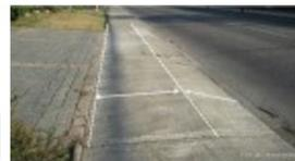
Foto 42: En los accesos vehiculares a viviendas debe respetarse la ruta accesible manteniendo una pendiente transversal máxima de 2% en el ancho que corresponde a la ruta.
