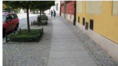
Foto 1: Ruta accesible en vereda, diferenciada en a través de un pavimento estable del resto de la acera de adoquines
