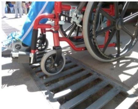
Figura 84. Rejillas dispuestas peligrosamente en la circulación peatonal.
