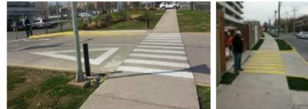
Foto 40 y 41: La ruta accesible se mantiene con preferencia sobre los vehículos demarcando la preferencia peatonal por sobre la vehicular
