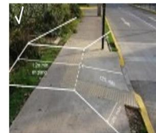
Foto 11 y 12: Ejemplo de cruce peatonal de 3 pendientes al cual se debe añadir espacio de la acera para sumar los 12m adicionales en plano que se requieren después del cruce.
