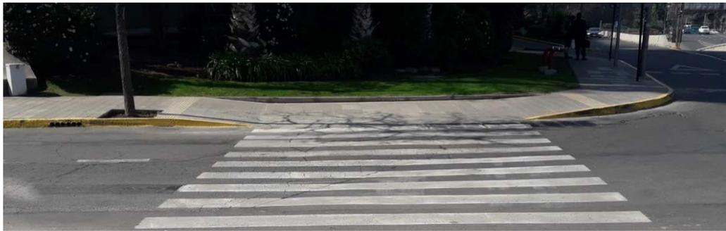
Figura 78. Cruce peatonal rebajado en todo su ancho hasta igualar la altura con la calzada.
