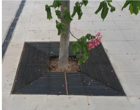
Figura 85. Protección de taza de árbol, correctamente entre enrasada y de color contrastante.
