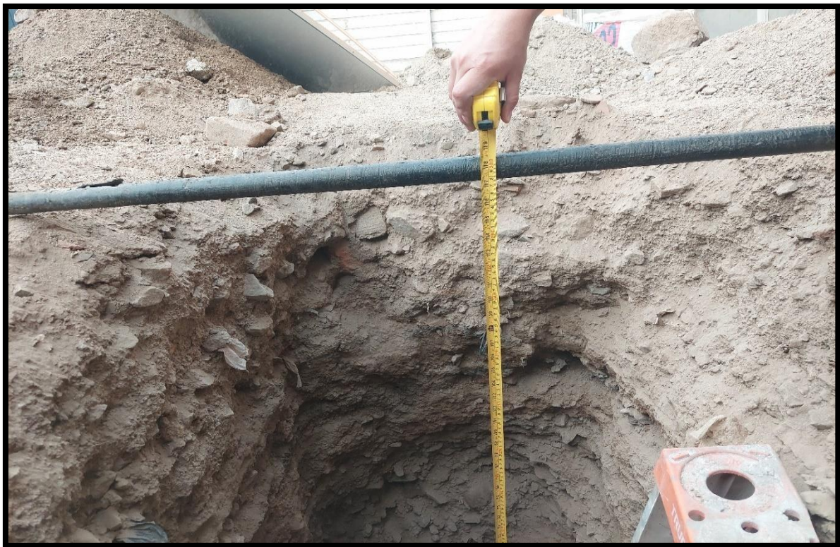
Foto 2: Vista panorámica de la profundidad de 3m en la calicata C-1
