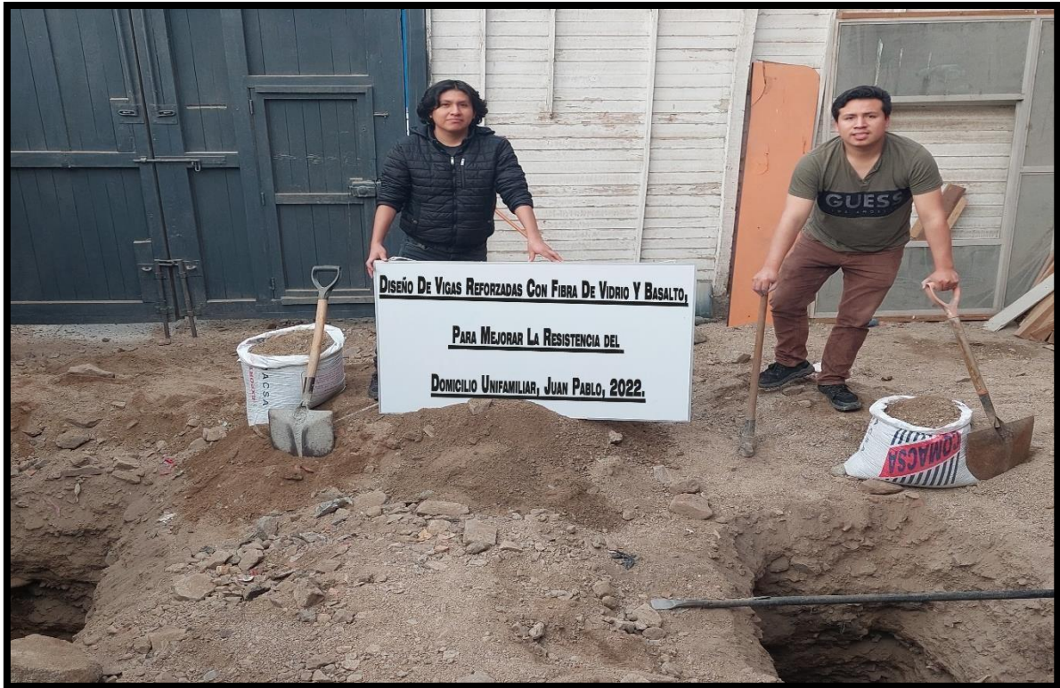
Foto 1: Vista panorámica de excavación de calicatas C-1 y C-2
