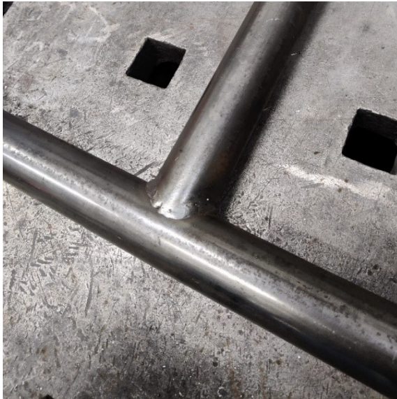
Kuva 8: Jalka- ja lattiaputken liitoshitsi.
