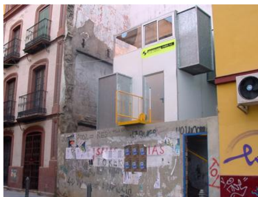
Figura 36. Vista del proyecto Casa Rompecabezas , realizado por Recetas Urbanas en Sevilla en 2002. ( https://recetasurbanas.net/ )
