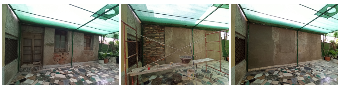
Figura 96. Tabicado de dos ventanas y una puerta , 2021. Tríptico. Fotografías digitales, 40 x 60 cm. (c. u.). La pared mide 320 x 600 cm. Se han utilizado diferentes ladrillos extraídos de partes demolidas de la casa.
