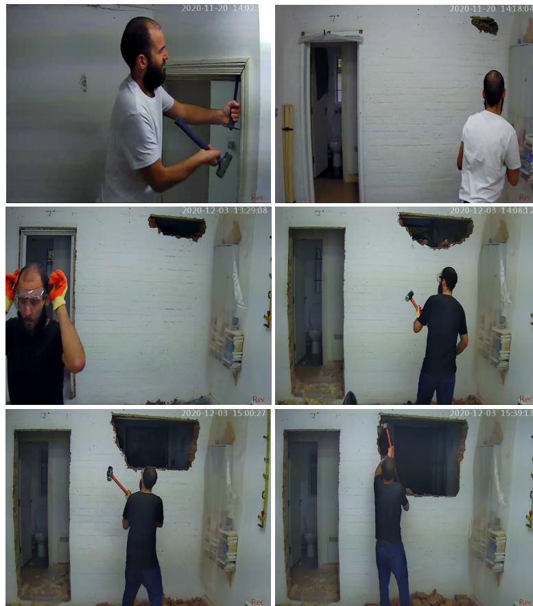
Figura 89. Proceso de demolición de una parte de nuestro estudio londinense, 2020.
