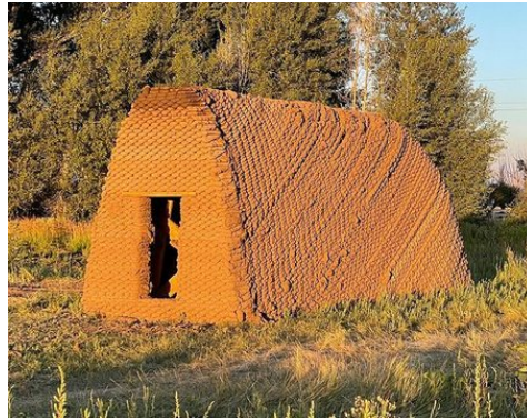
Figura 99. Cámara abovedada levantada mediante lodo impreso en 3D. 300 x 800 x 230 cm. Obra e imagen del diseñador Donald Rael en colaboración con estudiantes de UC Berkeley, 2019. ( https://www.instagram.com/p/CvsUeuxe7A/?utm_source )
