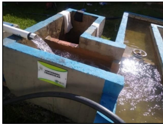
Fotografía 6. Canal de distribución y aforo de caudales.
