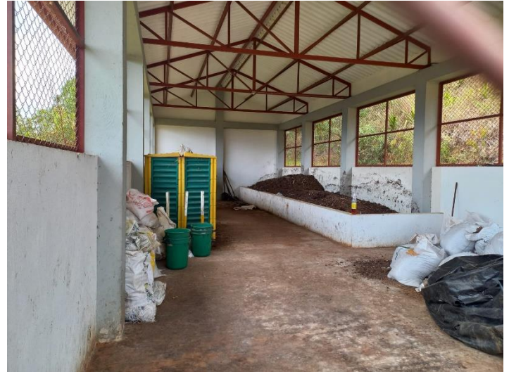
Figura 50. Interior de la planta de residuos orgánicos.
