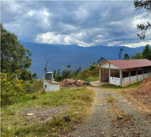
Figura 48. Planta de Tratamiento de Residuos Orgánicos.
