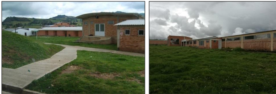
Figura 2. Vista de las instalaciones de la Clínica
