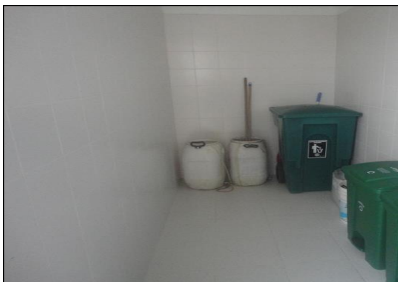
Figura 14. Cuarto de almacenamiento central residuos no peligrosos
