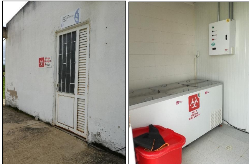
Figura 15. Cuarto de almacenamiento central de residuos peligrosos
