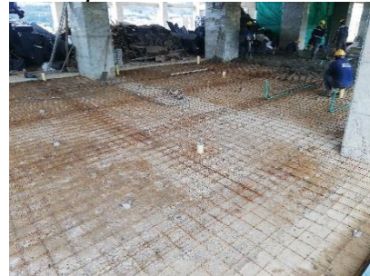
Figura 24. Malla electrosoldada para placa de contrapiso
