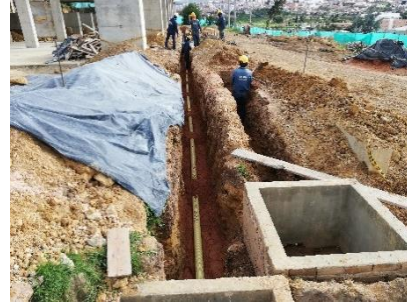
Figura 20. Instalación de tubería 110mm
