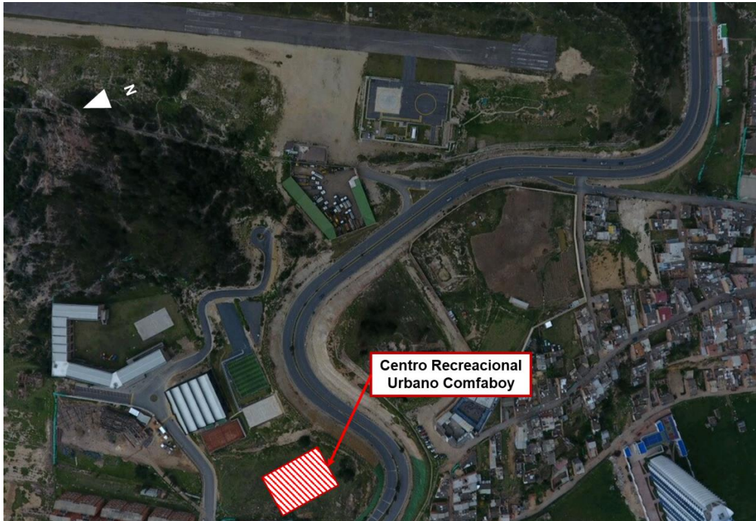
Figura 12. Foto aérea por dron, del complejo de servicios de Comfaboy, Tunja
