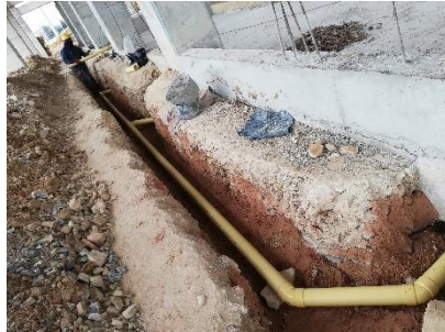
Figura 40. Tubería para red hidrosanitaria interna
