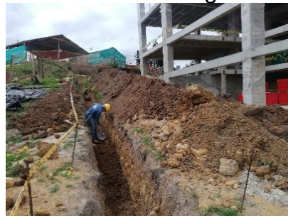
Figura 18. Excavación externa red de desagües
