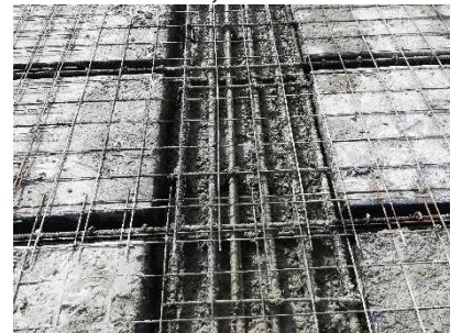
Figura 28. Fundida de vigas aéreas N+19,30
