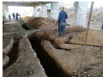
Figura 38. Excavación para red hidrosanitaria
