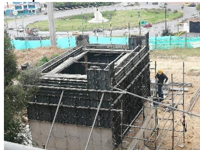
Figura 37. Fundida de fondo y paredes de tanque de compensación
