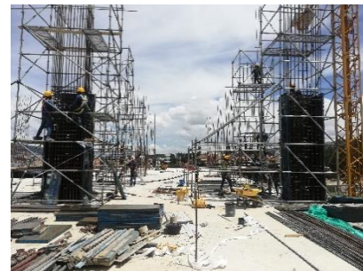
Figura 27. Fundida de columnas
