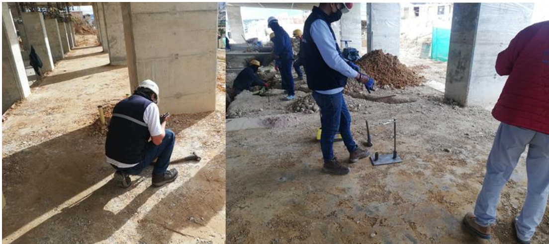
Figura 50. Ensayo de densidad de compactación del suelo
