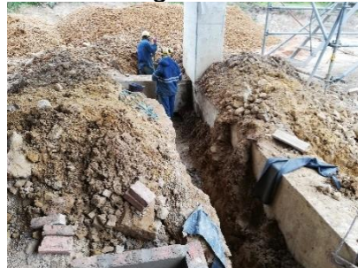
Figura 17. Excavación para red de desagües
