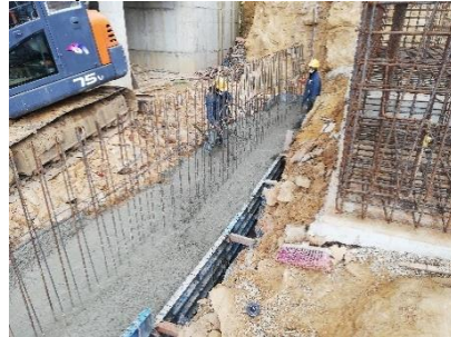
Figura 34. Fundido muro de contención con concreto ciclópeo
