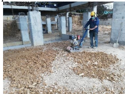
Figura 22. Compactado con plancha vibratoria
