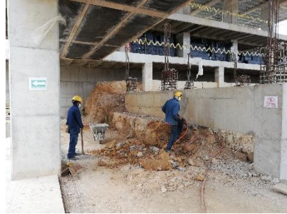
Figura 23. Excavación con compresor
