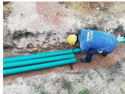
Figura 15. Instalación tubería media tensión
