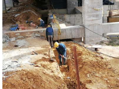
Figura 16. Excavación red de abastecimiento de agua
