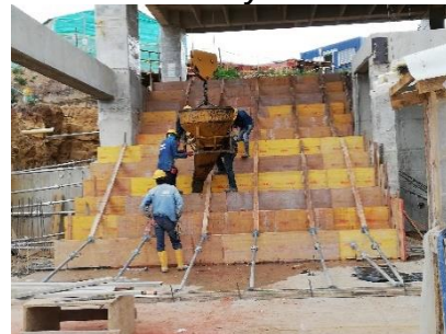
Figura 32. Fundida de escaleras Lobby
