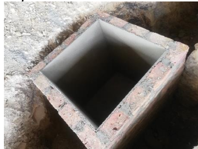
Figura 41. Caja de inspección interna
