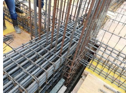
Figura 26. Acero de nudo de viga con columna
