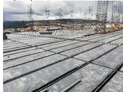
Figura 31. Casetón en icopor placa N+19,30
