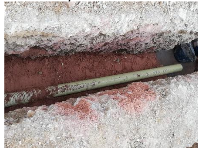
Figura 21. Relleno con arena de peña
