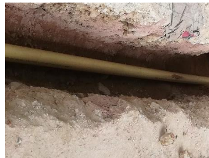
Figura 20. Instalación de tubería 110mm
