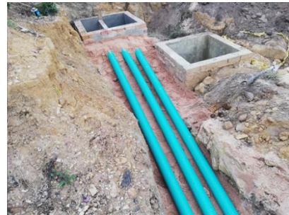
Figura 15. Instalación tubería media tensión
