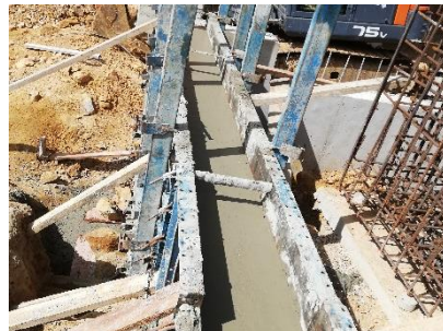
Figura 35. Fundida de muro de contención
