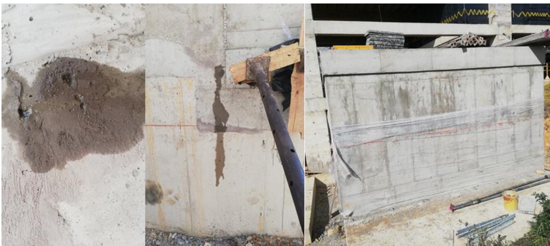
Figura 51. Prueba de estanqueidad en tanque de compensación
