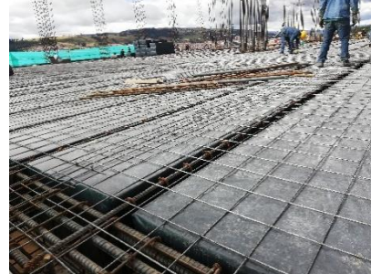
Figura 29. Instalación malla electrosoldada placa N+19,30
