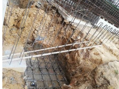
Figura 33. Acero de muro de contención
