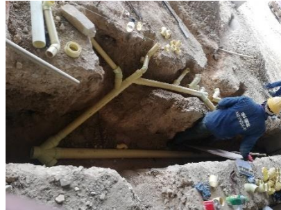
Figura 40. Tubería para red hidrosanitaria interna
