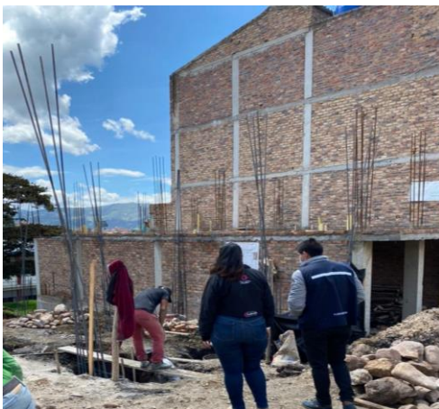
Figura 20. Visita realizada a obra en el rincón del Cargua
