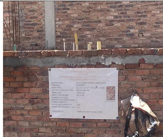
Figura 21. Revisión de valla de aviso a terceros
