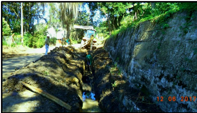
Figura 29. Excavación para filtro.
