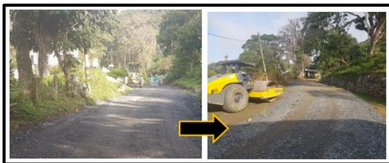
Figura 40. Extendido, nivelación y compactación de la subbase granular.
