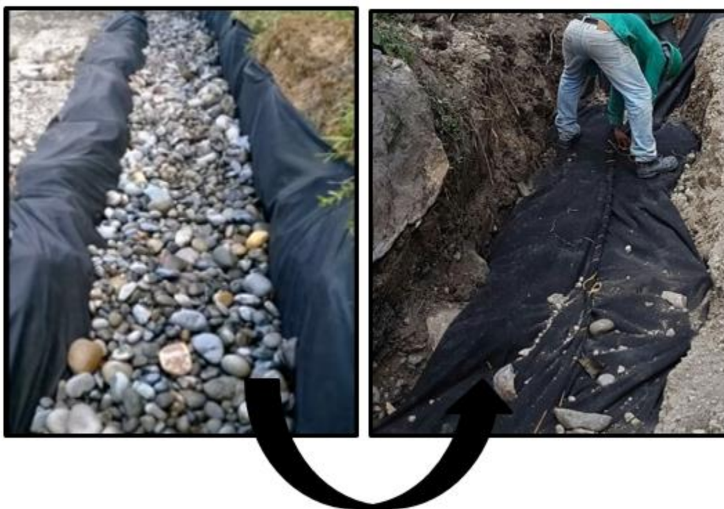
Figura 32. Disposición del material granular filtrante y cosido del geotextil.
