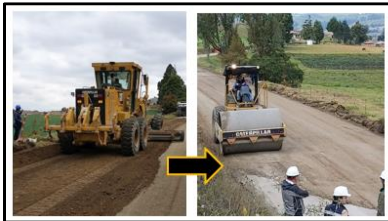
Figura 38. Extendido y compactación del material para mejoramiento de subrasante.
