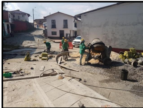
Figura 44. Fundida e instalación del concreto clase D.
