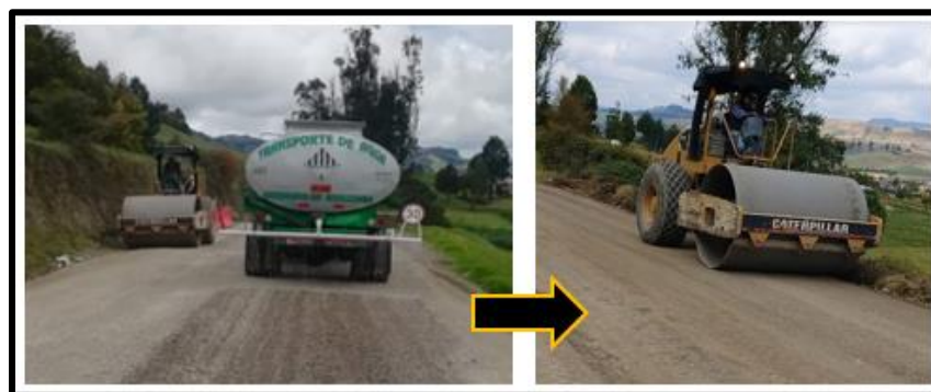
Figura 37. Humectación y compactación de la subrasante.
