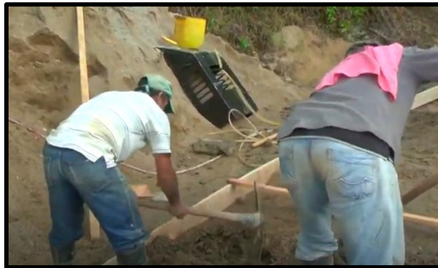
Nota: Fotografía de la excavación manual para vigas riostras. Abscisa K1+142. Fuente: Convenio 918 de 2014 UPTC – INVIAS.
