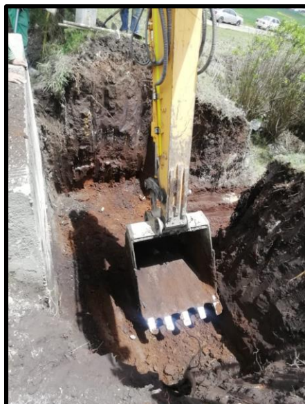
Figura 24. Excavación en material común para alcantarillas
