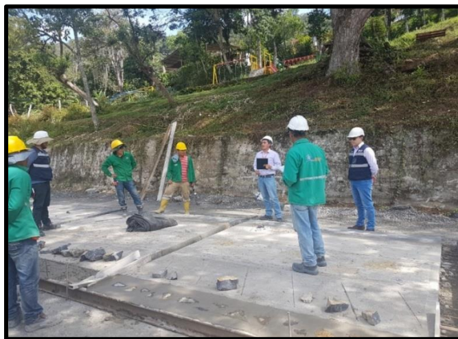
Figura 49. Charla de capacitación al personal de la obra.
