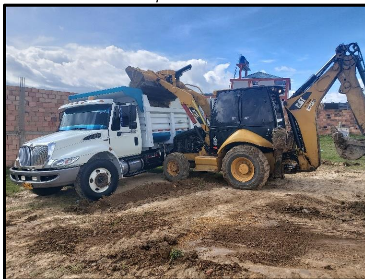
Figura 35. Excavación en material común seco para conformar la vía.
