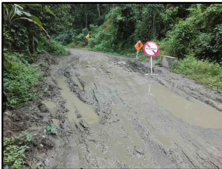
Figura 33. Condiciones de la vía previo a la implementación de la placa huella
