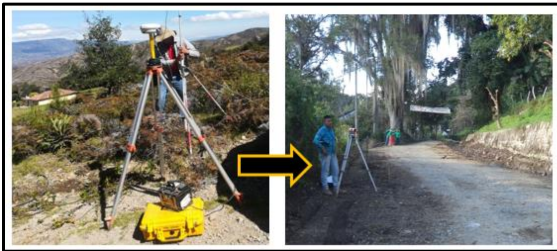
Figura 34. Localización y replanteo topográfico del eje de proyecto
