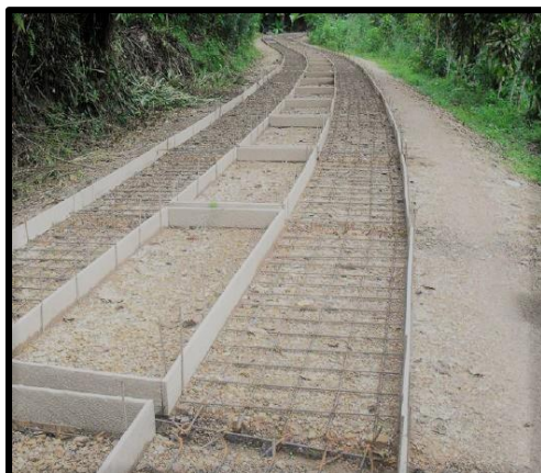
Figura 42. Disposición de la formaleta para las huellas de concreto
