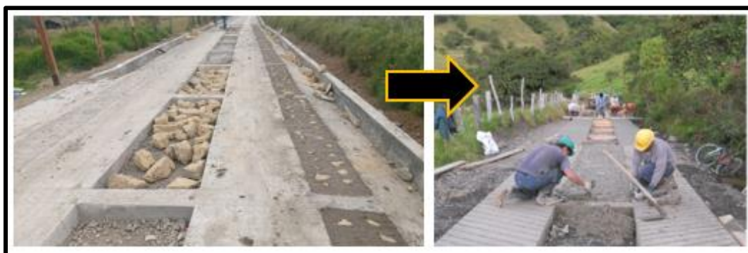
Figura 46. Construcción de las franjas en concreto clase G.
