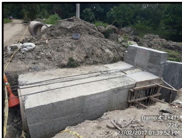
Figura 26. Concreto clase D empleado para la alcantarilla
