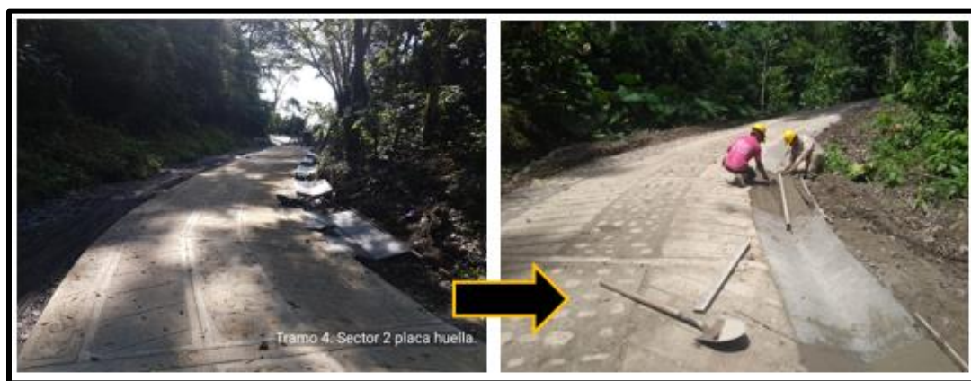
Figura 47. Construcción de cunetas para la placa huella.
