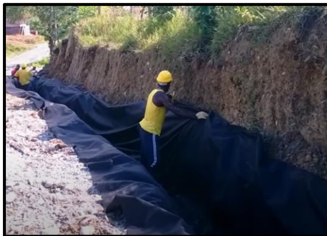
Nota: Fotografía de la utilización del geotextil para el filtro en el k1+270. Fuente: Convenio 918 de 2014 UPTC – INVIAS.
