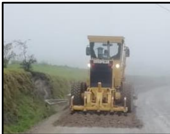
Figura 36. Escarificación de la subrasante.
