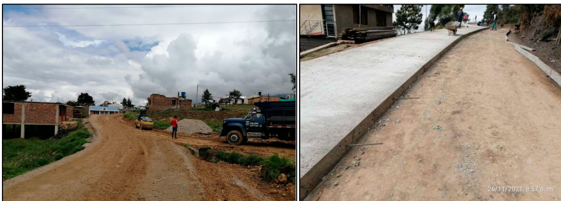
Figura 9. Construcción del tratamiento superficial doble y pavimento rígido
