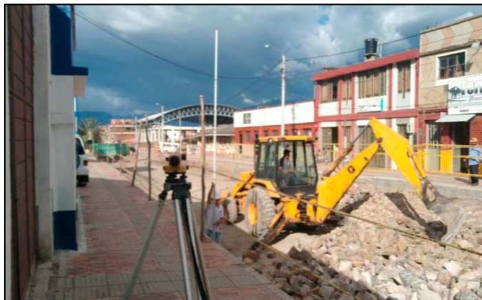
Figura 10. Construcción del pedraplén
