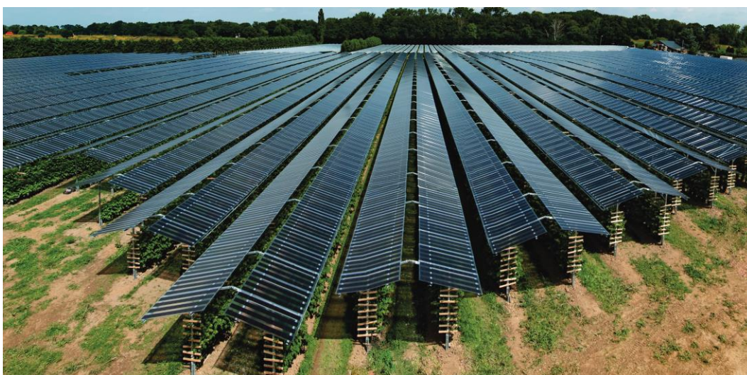
Abbildung 12: Anlagenbeispiel für Bewirtschaftungsstatus "Dauerkulturen" und «geschützter Anbau». Agri-PV-Anlage über Himbeeren in Zevenaar (Niederlande). Mit der APV-Anlage konnten Folientunnel substituiert werden. Die Folientunnel sind hinter der APV-Anlage ersichtlicher. Es kommen semitransparente PV-Module mit einer Lichtdurchlässigkeit von 54 % zum Einsatz (GroenLeven, o. J.).
