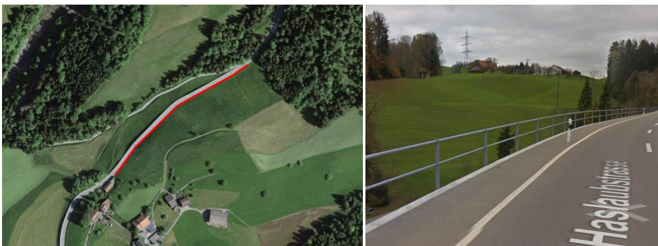
Abbildung 45: Stützmauer Waldhalden an der Haslaubstrasse südlich von Schönenberg links (geo.admin) als rote Linie. Das Objekt befindet sich auf der von der Strasse abgewendeten Seite (rechts) mit Süd-Südöstlicher Ausrichtung (Google Streetview). Es ist 297 m lang und 3 m hoch. Die maximale Modulfläche beträgt 892 m 2 , die Nennleistung bis zu 178 kWp.
