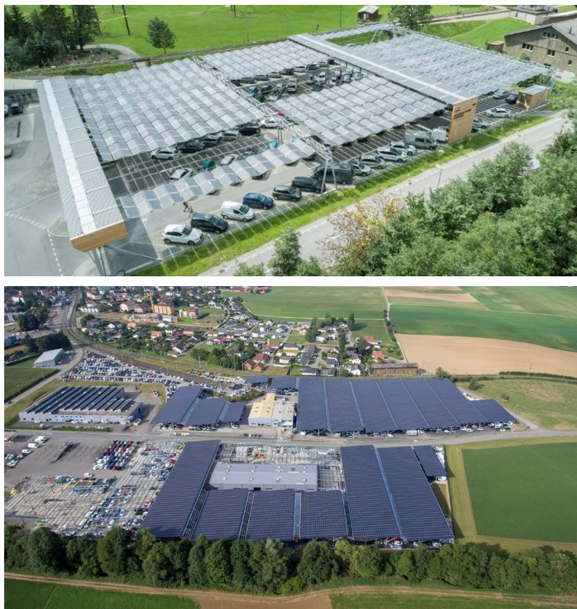
Abbildung 19 Referenzanlage für komplett überdachte Parkplätze der dhp technology AG (o.) und von AdiWatt SA (u.)
