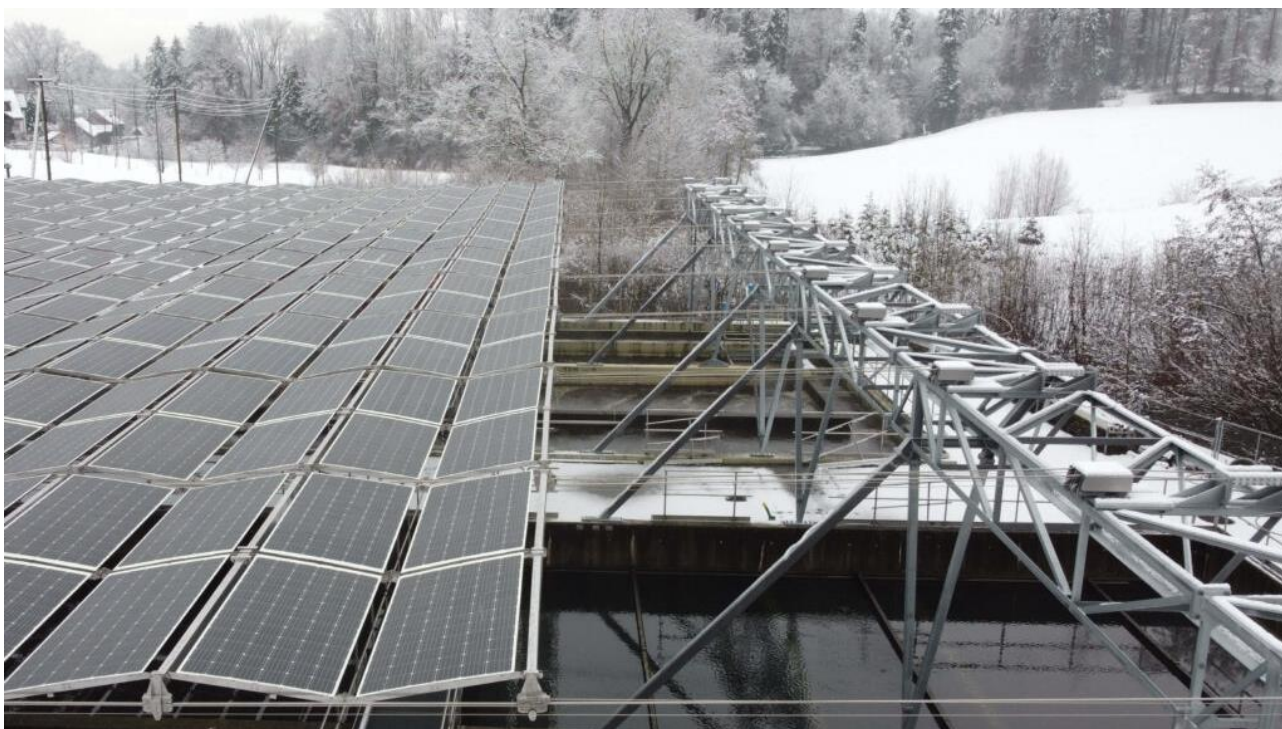
Abbildung 30: Solarfaltdächer ARA Egg-Oetwil (ZH), realisiert 2021.
