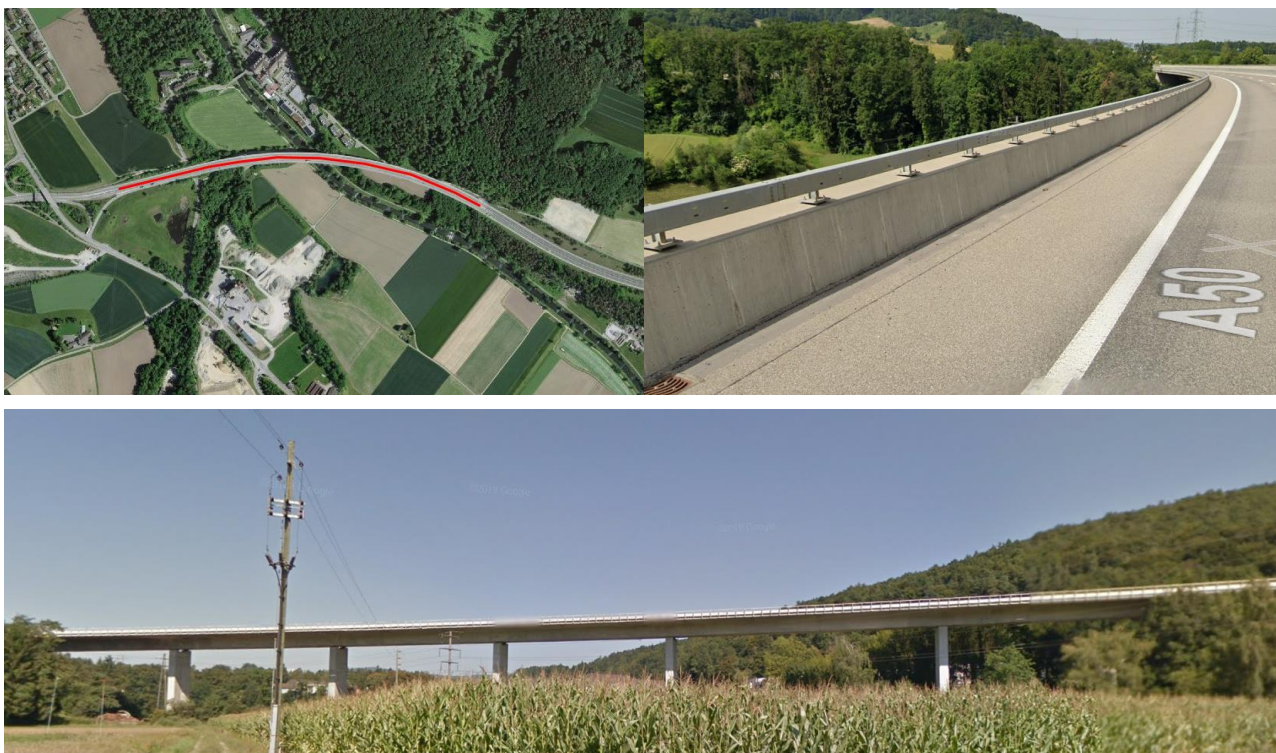
Abbildung 46: Lättenbrücke an der A50 bei Glattfelden. Satellitenbild mit rot eingezeichneter Brücke oben links (geo.admin), Ansicht von der Strasse gegen Südwesten oben rechts (Google Streetview) sowie Fernansicht aus Süden unten (Google Streetview). Die Brücke liesse eine Modulfläche von ca. 650 m 2 respektive eine PV-Anlage mit 130 kWp auf der Südseite der Brücke zu.
