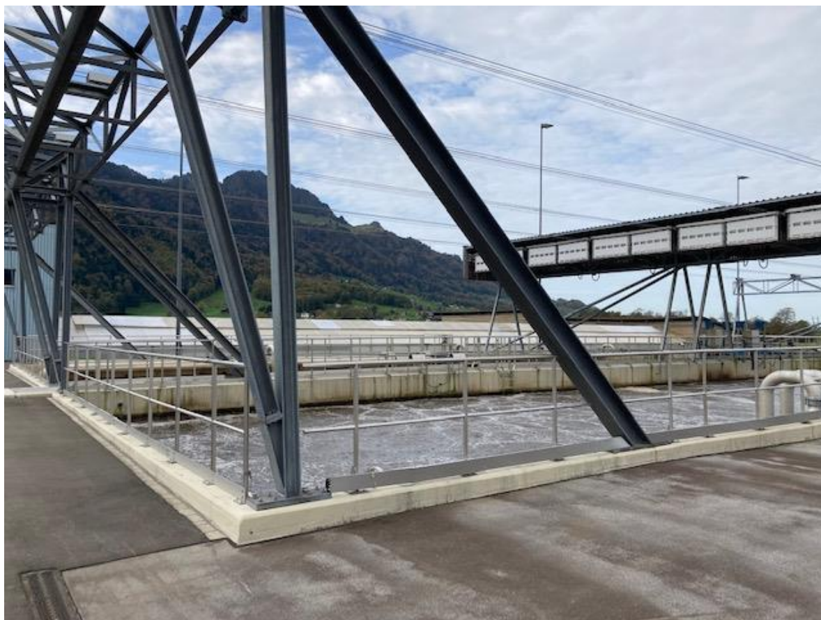
Abbildung 36: Fundament Faltdachsysteme auf Rechteckbecken. Foto ARA Glarnerland 2022.
