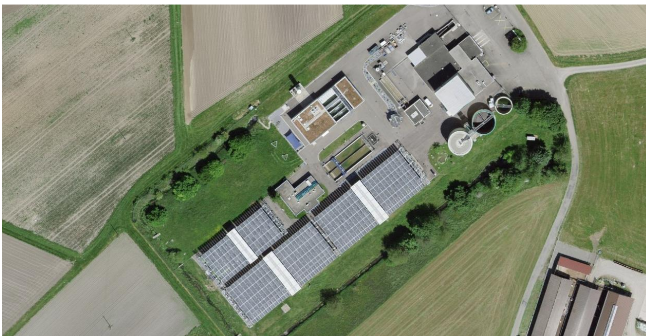
Abbildung 31: Luftbild ARA Bassersdorf mit realisierter Faltdach-PV-Anlage über den Klärbecken (geo.admin.ch).
