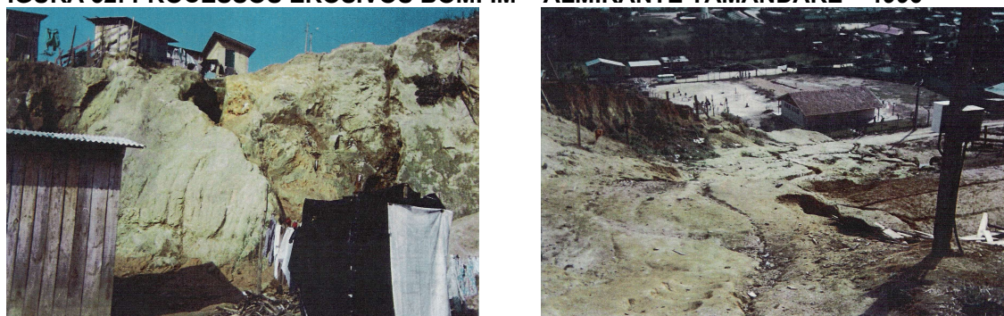
FIGURA 32: PROCESSOS EROSIVOS BOMFIM – ALMIRANTE TAMANDARÉ – 1996
