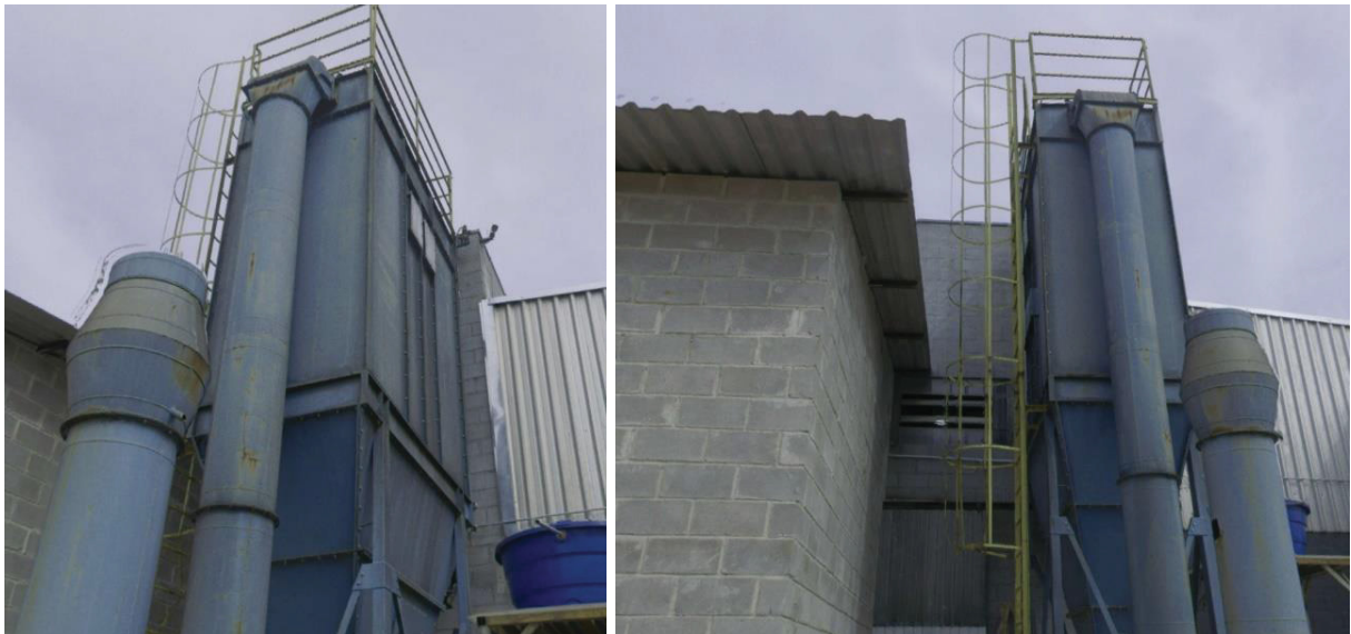
FIGURA 15 – IMAGENS DA ÁREA UTILIZADA PARA O TREINAMENTO EM ALTURA
