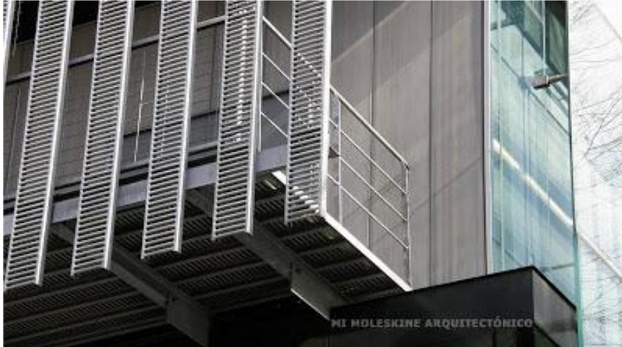
FIGURA 30 - ESCADAS DE EMERGÊNCIA COBERTAS PELA TRAMA METÁLICA NA FACHADA OESTE
