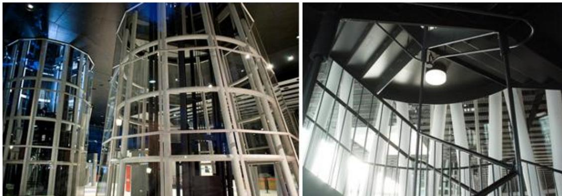
FIGURA 25 - TUBOS QUE FUNCIONAM COMO ELEMENTO ESTRUTURAL, CIRCULAÇÃO VERTICAL, INSTALAÇÕES ELÉTRICAS E HIDRÁULICAS E ILUMINAÇÃO ZENITAL
