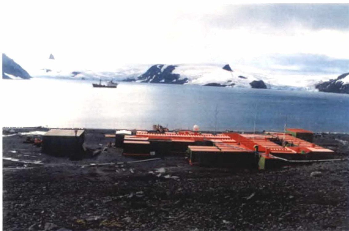
Fig 2 a: Estação Antártica Comandante Ferraz, em vista frontal, observando-se o módulo Laboratório (↓) e o módulo Laboratório Frio (▼). Fig. 2.b: Estação Antártica Comandante Ferraz em vista posterior, às margens da Baía do Almirantado.
