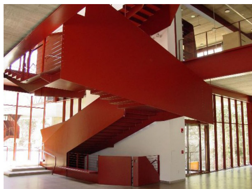
Figura 57 – Escada metálica Fonte: www.art.uiowa.edu
