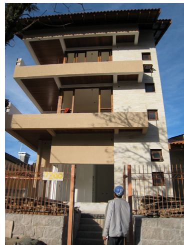
Figura 31 – A sede em construção Fonte: Sílvia Matsune, maio de 2008
