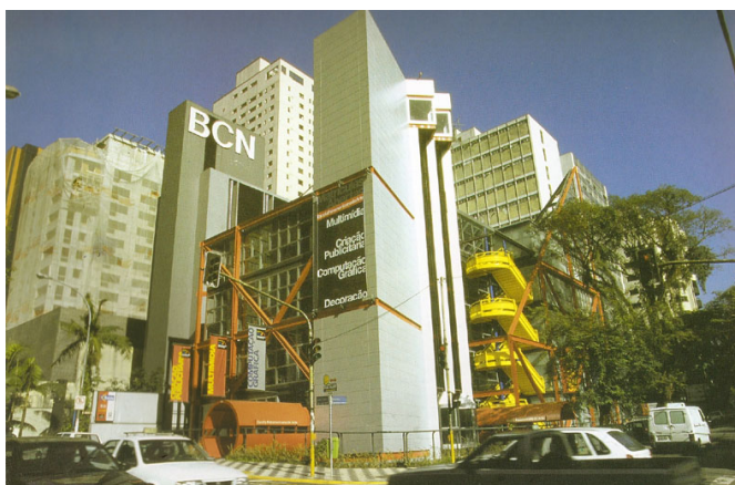
Figura 38 – Vista da Escola
