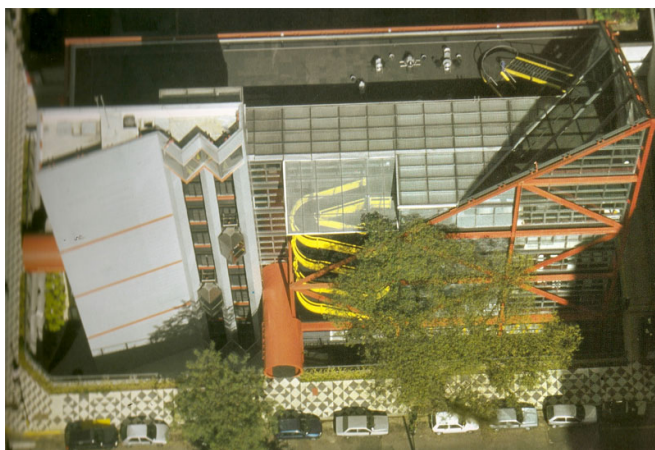
Figura 39 – Vista da Escola
