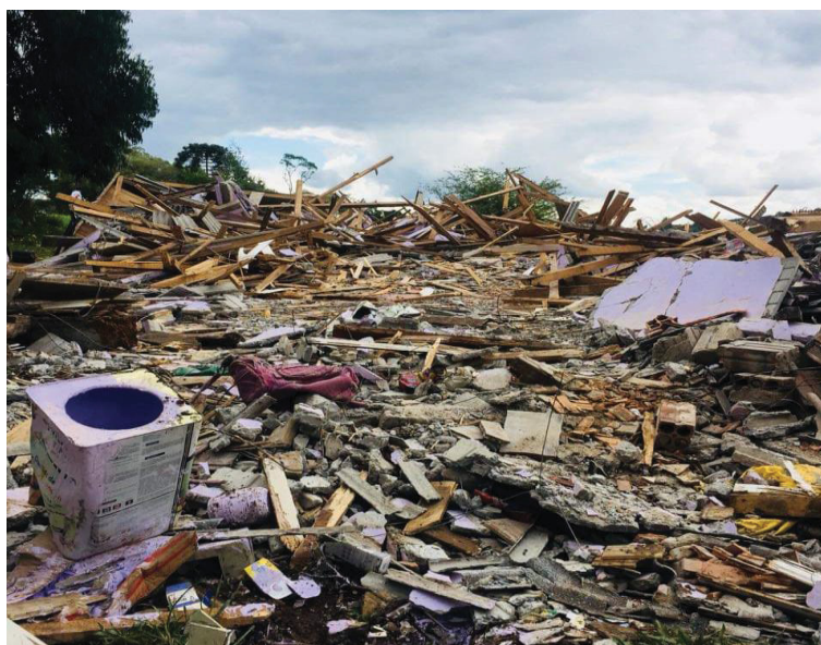
Figura 17 – Despejo nas terras do Alecrim: Demolição
