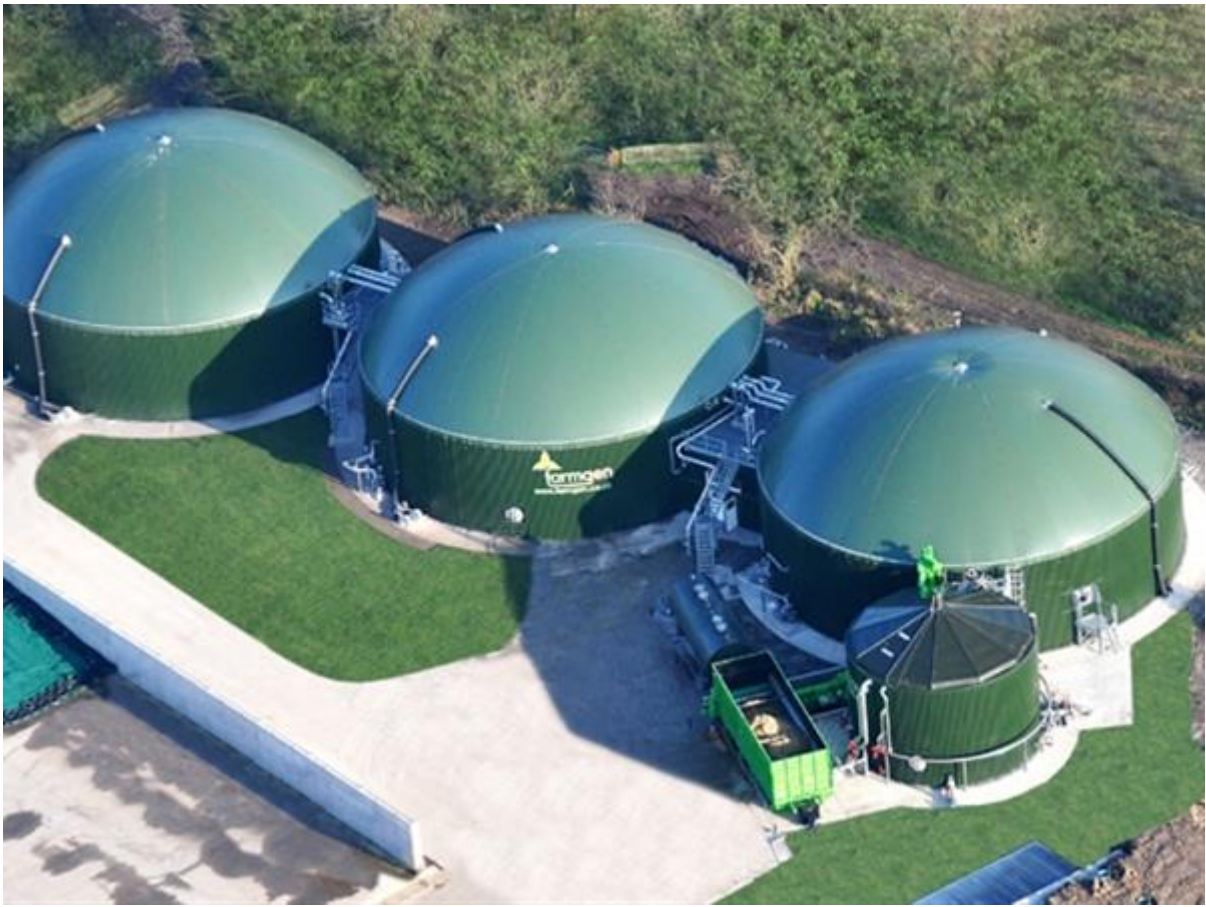
IMAGEM 3 - BIODIGESTOR DE GRANDE PORTE NO NORTE DA INGLATERRA NA CIDADE DE SILLOTH.
