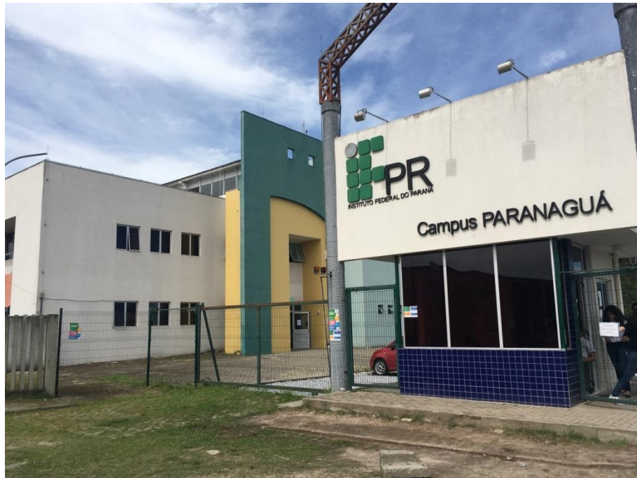
FIGURA 7 - INSTITUTO FEDERAL DO PARANÁ – IFPR CAMPUS PARANAGUÁ (FONTE: ACERVO PRÓPRIO).
