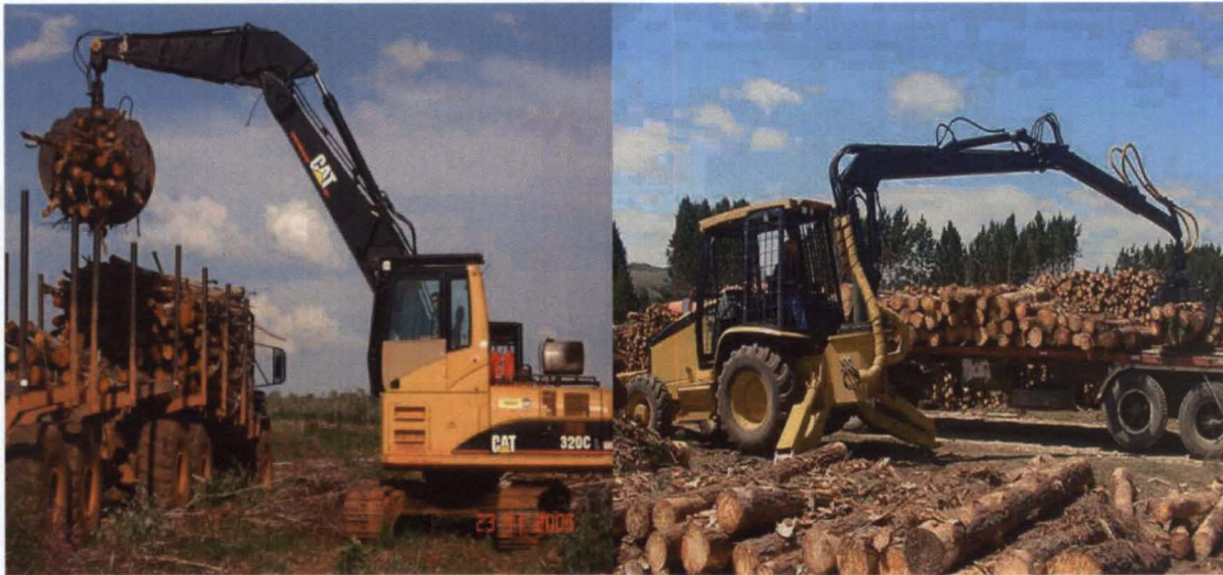
FIGURA 8 – Carga de toras mecanizada dentro do talhão Escavadeira Hidráulica, e na beira da estrada, Carregador florestal.
